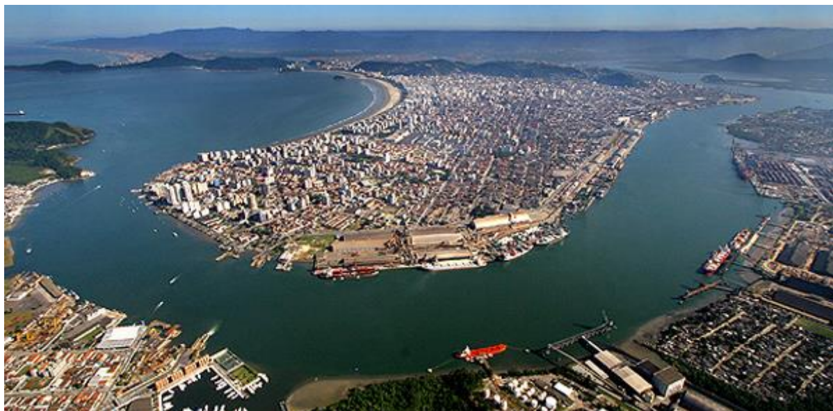
Figura 4.7 – Vista aérea do Porto de Santos-SP Fonte: Colombo (2012)
