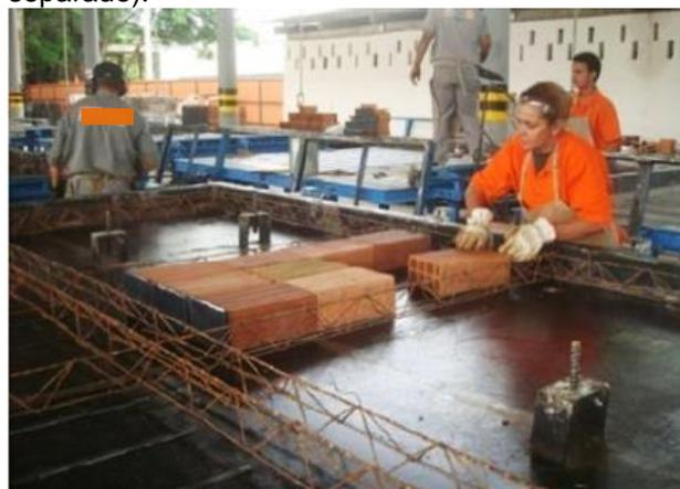
(d) Detalhe dos blocos entre as armaduras.
