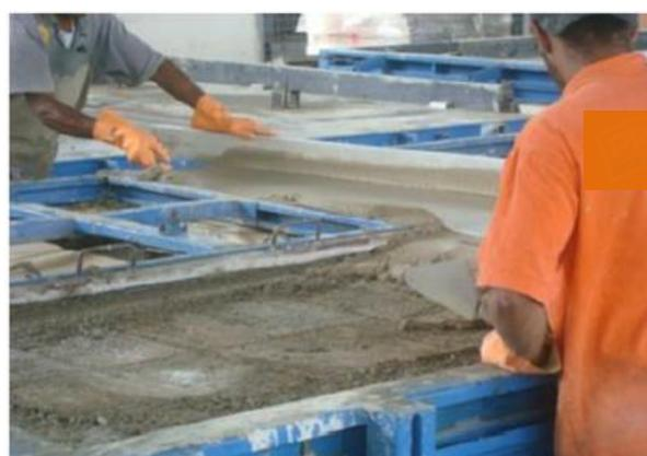
(h) Aplicação de argamassa na face superior (externa) do painel e finalização com régua metálica.
