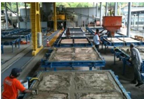
(g) Concretagem das nervuras dos painéis com auxílio de vibrador de imersão
