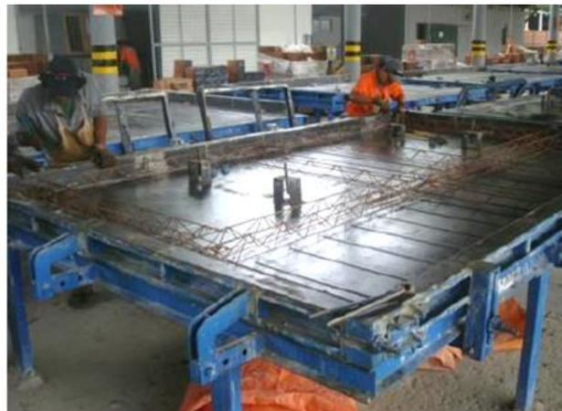
(b) Distribuição de armaduras previamente preparadas na central de armação (galpão separado).
