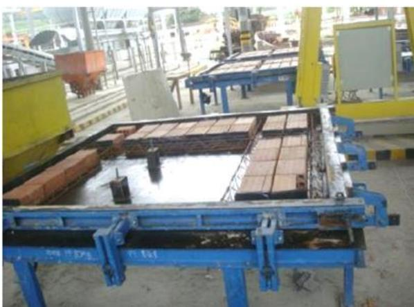
(c) Posicionamento dos blocos cerâmicos que tem seus furos posteriormente tamponados com capas plásticas.
