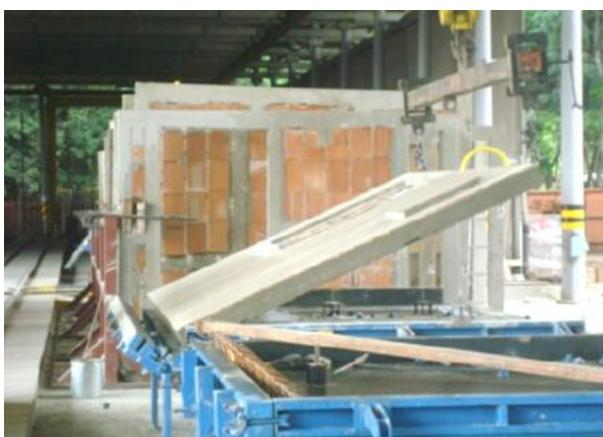
(i) Após 16 horas verifica-se a resistência do painel e procede-se sua desenforma.
