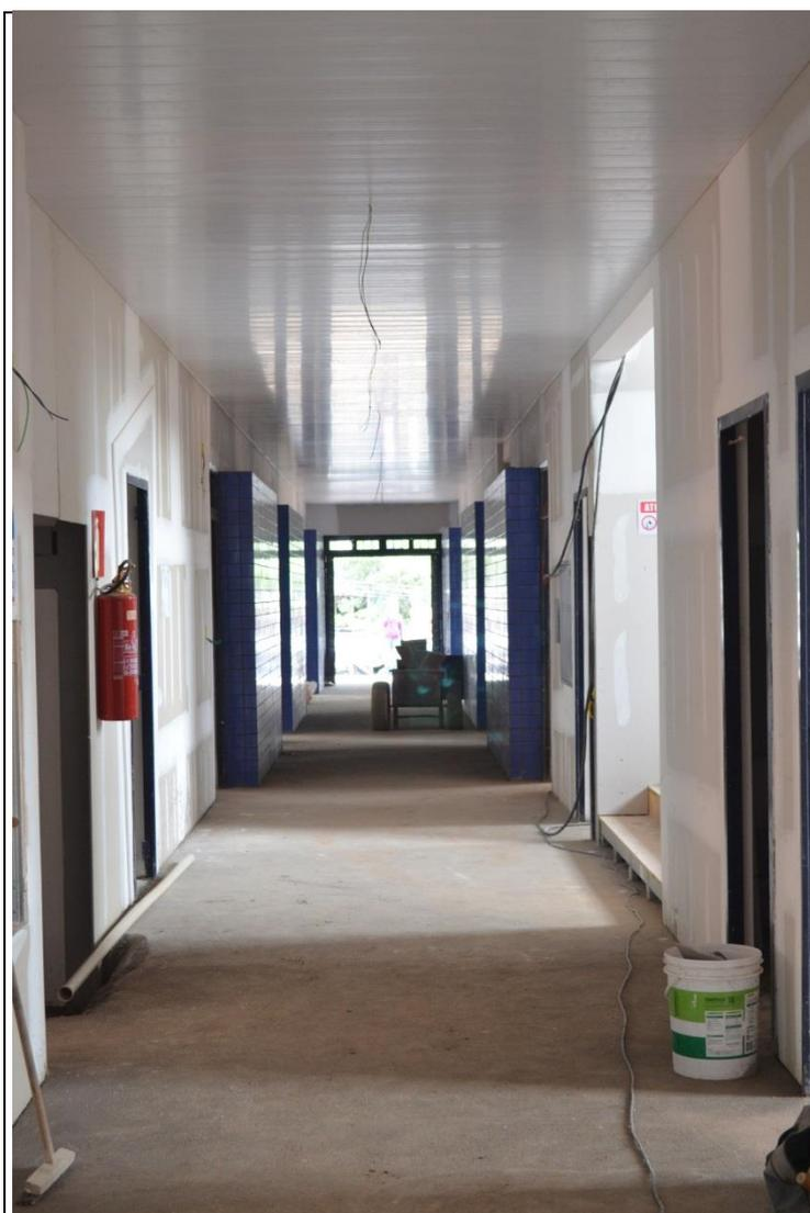
**ETAPA 8-** Acabamentos internos com instalação de forros, vidros, revestimentos cerâmicos, piso vinílico, louças e peças fixas; e pinturas (o).
