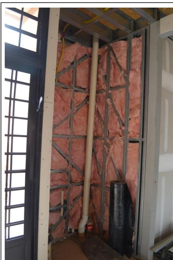
**ETAPA 7-** Vedação interna da 1ª face dos painéis com gesso acartonado e preenchimento acústico e térmico em lã de vidro (m). Fechamento da 2ª face dos painéis com gesso acartonado e instalação de esquadrias (n).
