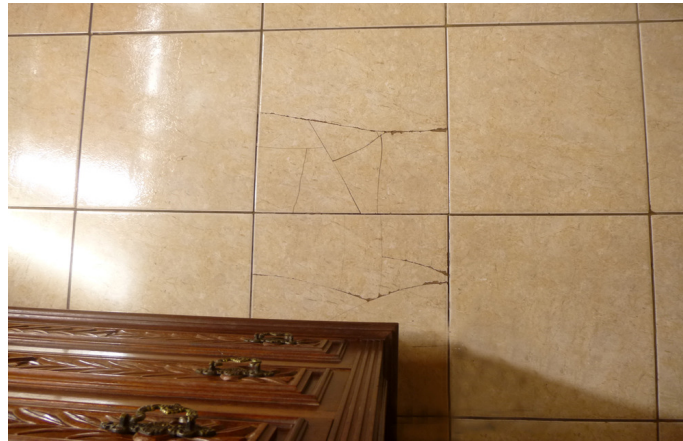
Figura 16 : Desgaste mecânico
