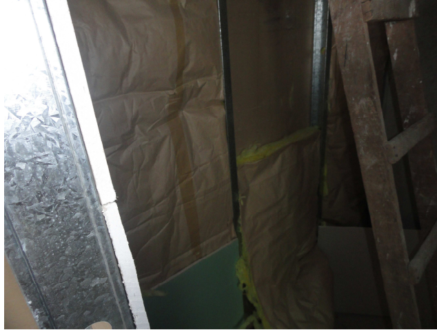
Figura 33 - Colocação de lã mineral dentro da estrutura de gesso acartonado para redução de ruídos e melhor eficiência na manutenção da temperatura entre os ambientes (LABUTO, 2013)
