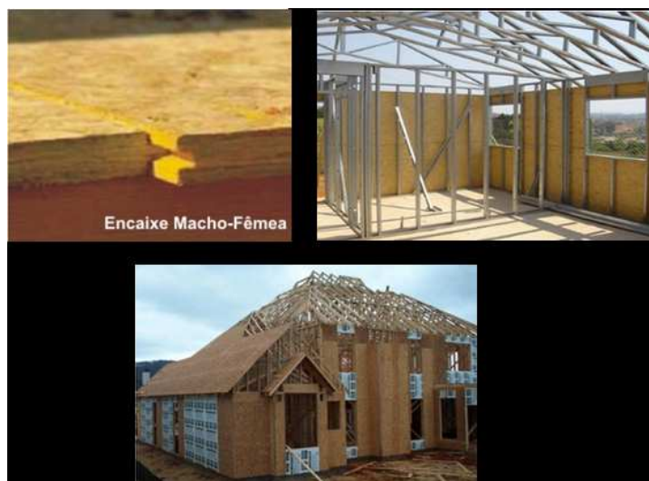
Figura 3 - Placas e sistemas de construção com placas OSB ( Oriented Strand Board ) (CENTERPLASTER, 2013).
