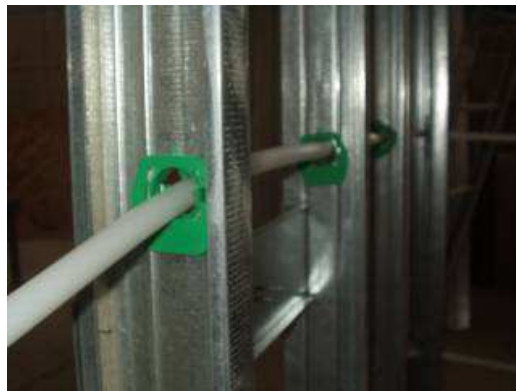
Figura 30 - Passagem de tubulação PEX no montante com passador para proteger a tubulação contra desgastes da parede e possíveis cortes. ( http://www.dbgraus.com.br/dB_arquivos_html/pex.htm , 2013)
