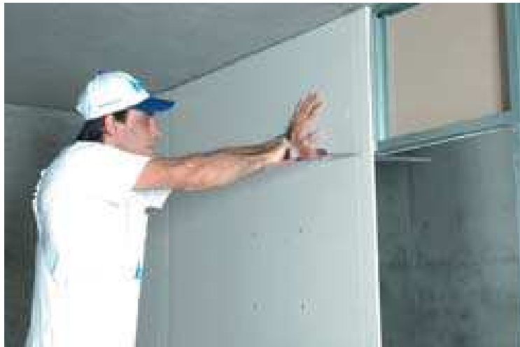
Figura 34 - Corte da chapa no vão de porta. (KNAUF, 2009)
