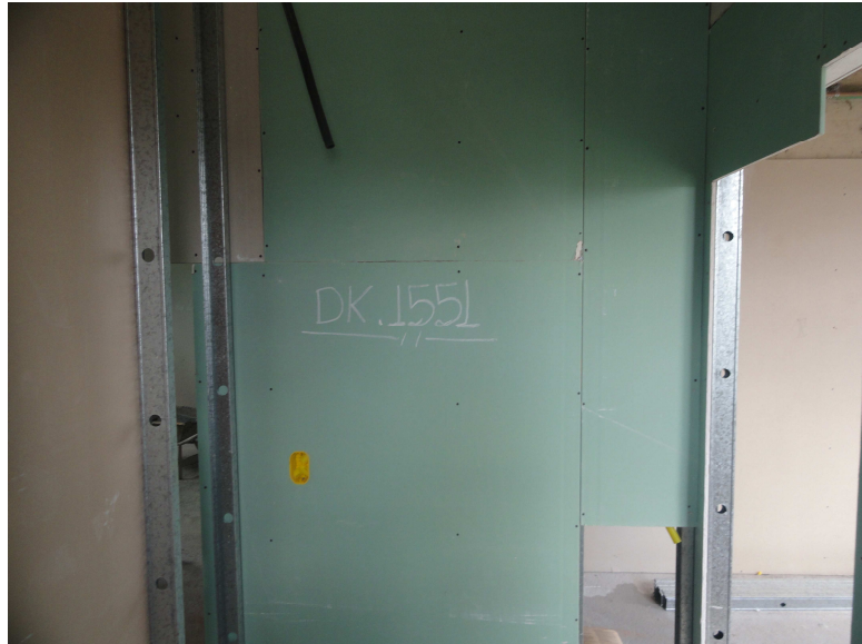
Figura 35 - Corte da chapa no vão de porta. (LABUTO, 2013)
