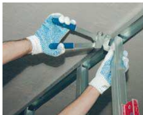
Figura 23 - Fixação dos montantes nas guias (KNAUF, 2009)
