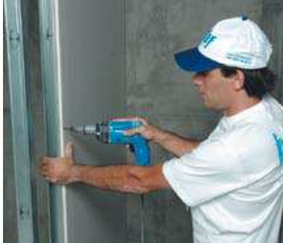
Figura 25 - Fechamento de um dos lados da parede de Drywall . (KNAUF, 2009)
