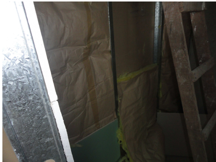
Figura 18 - Paredes em drywall com material em lã de vidro como isolantes termo acústicos. (LABUTO, 2013)
