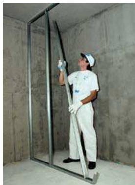
Figura 22 - Colocação dos montantes nas guias (KNAUF, 2009)
