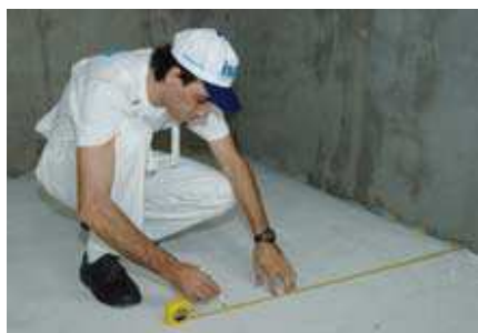
Figura 20 - Locação do posicionamento das paredes. (KNAUF, 2009)
