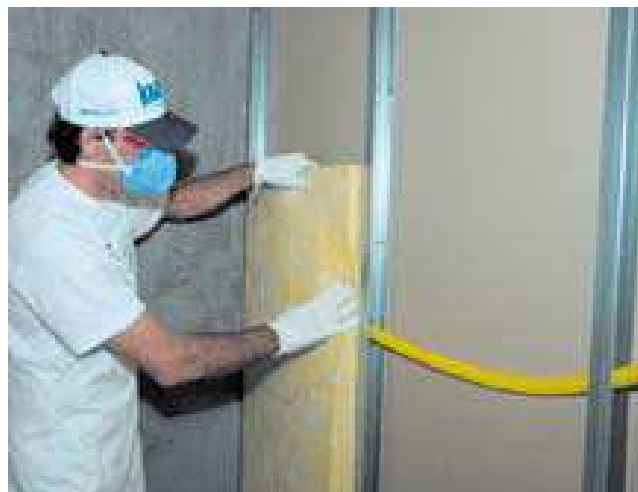
Figura 32 - Colocação de lã mineral dentro da estrutura de gesso acartonado para redução de ruídos e melhor eficiência na manutenção da temperatura entre os ambientes (KNAUF, 2009)
