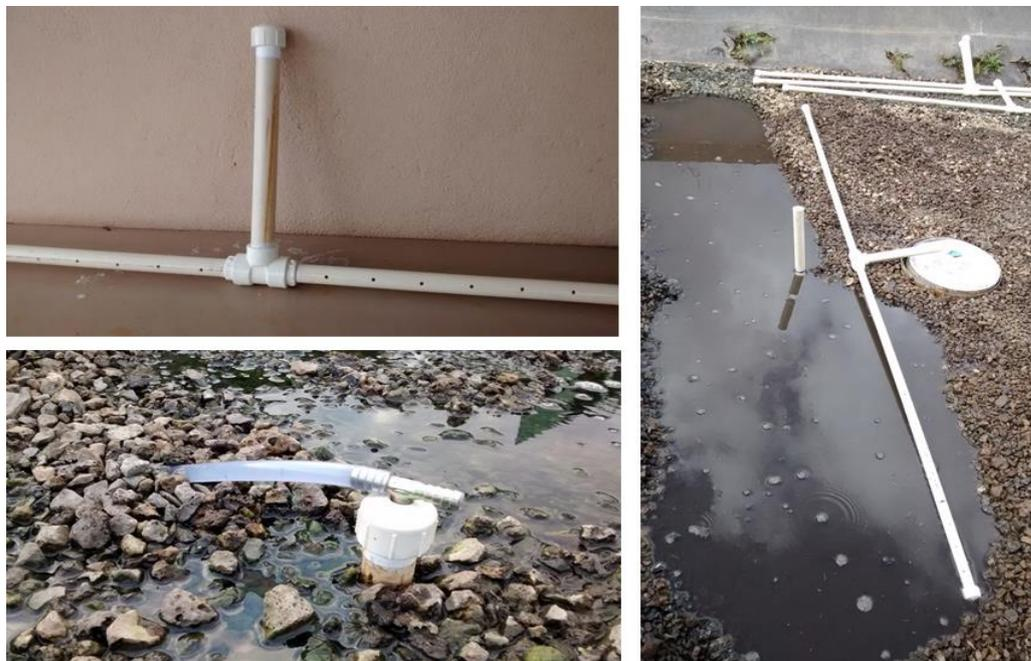
Figura 4.10: Características e instalação do poço de monitoramento. Detalhe do poço (superior esquerda), instalação do poço (direita) e poço instalado (inferior esquerda).
