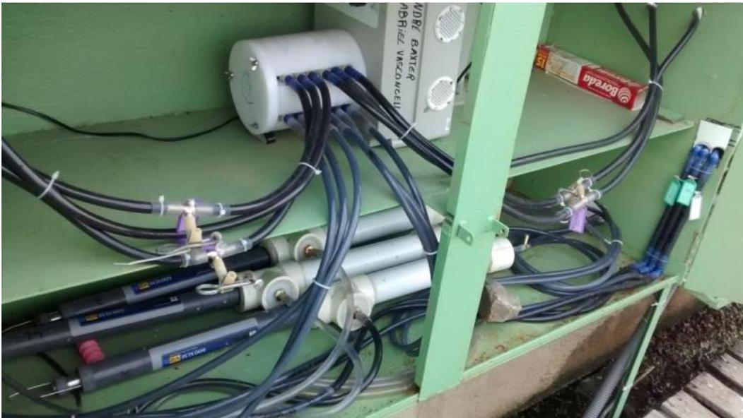
Figura 4.13: Interior do abrigo da bomba peristáltica.
