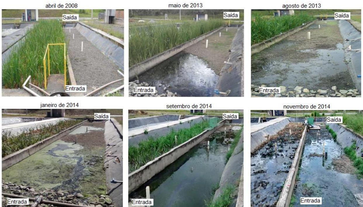
Figura 4.2: Evolução do escoamento superficial no Sistema Alagado Construído.
