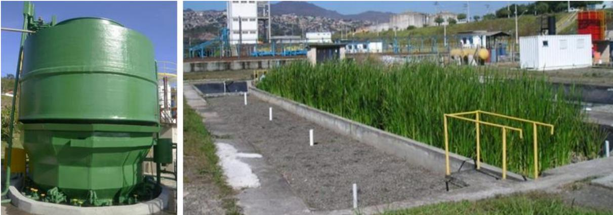
Figura 4.1: Reator UASB (esquerda) e os Sistemas Alagados Construídos (direita).
