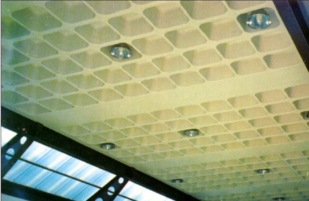
Figura 2 – Laje com nervuras aparentes ( LATEX, 2001 ).
