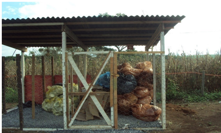
FIGURA 8 – Baias para armazenamento temporário de resíduos Fonte: A Autora
