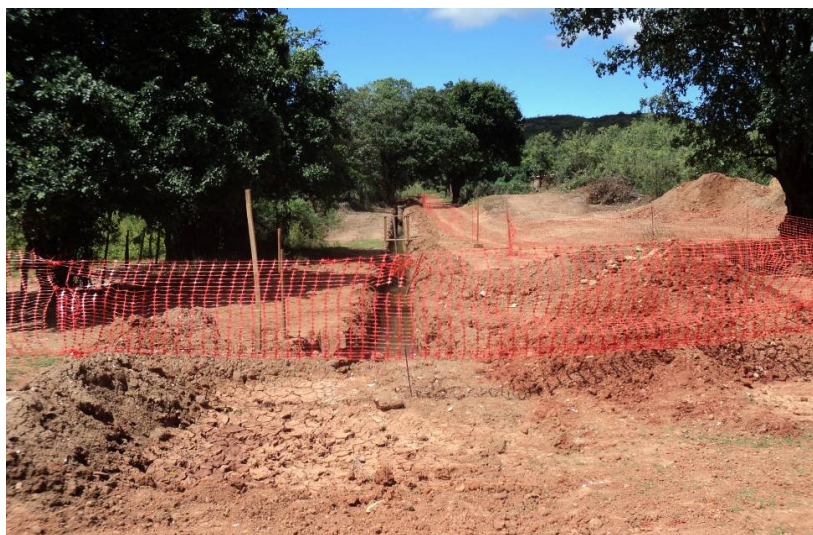
FIGURA 6 – Sinalização da área de obra Fonte: A Autora
