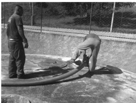
Figura 4.15 – Detalhe da remoção de espuma do separador trifásico, por escotilhas.
