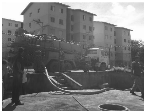
Figura 4.16 – Detalhe da remoção de espuma do separador trifásico, por mangote de sucção e caminhão limpa-fossa.
