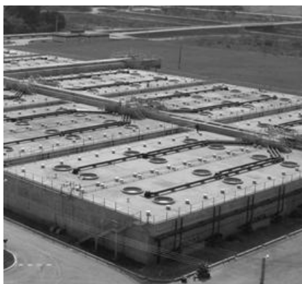
Figura 4.7 – Vista dos reatores UASB da ETE Onça, em Belo Horizonte no Brasil.
