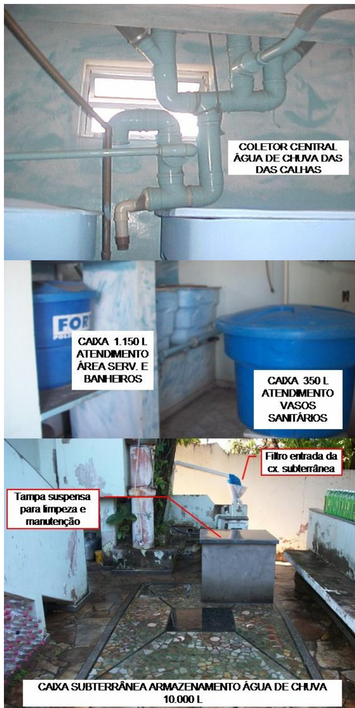
FIGURA 5 – Detalhamento do sistema alternativo de uso de água de chuva Fonte: Elaborada pelo autor
