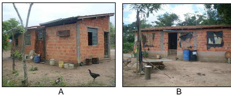
FIGURA 10 - A e B - Casa de Alvenaria no Assentamento Estrela do Norte Fonte: TRABALHO DE CAMPO, 2011.
