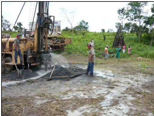
FIGURA 18 - Perfuração do poço artesiano Fonte: ARQUIVO PESSOAL.
