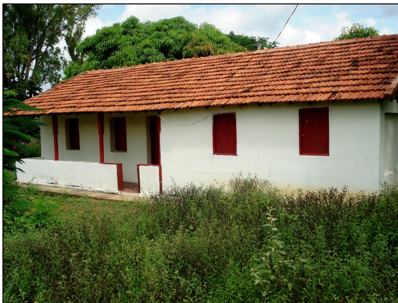
FIGURA 11 - Sede da Associação do Assentamento Estrela do Norte, que foi reformado e, atende também, os serviços de saúde Fonte: TRABALHO DE CAMPO, 2010.
