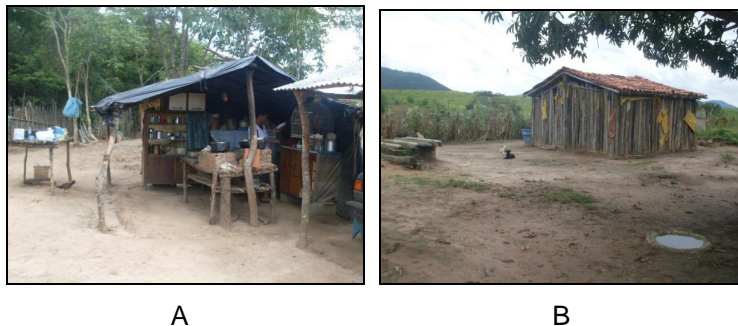
FIGURA 8 - A . Cozinha construída com madeira e lona; B- Casa feita de madeira e lona Fonte: TRABALHO DE CAMPO, 2011.
