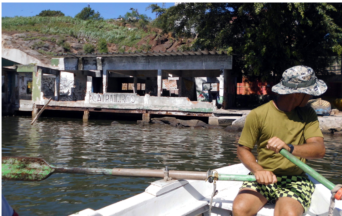
Figura 57 - Chegada ao atracadouro dos catraieiros em Paul. As instalações precárias não possuem banheiro, água ou energia elétrica (2015).
