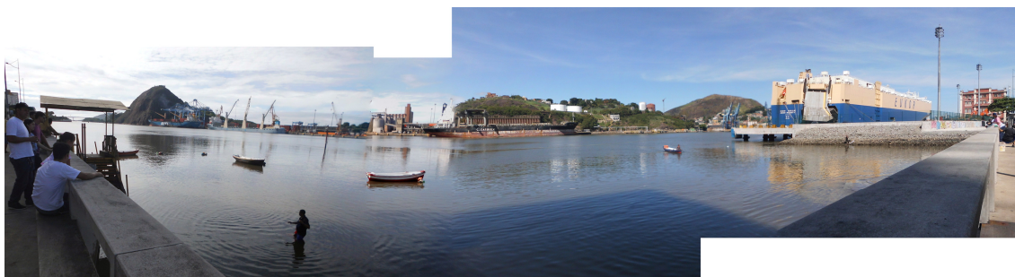
Figura 29 - Obras de expansão do Berço 101 do Porto de Vitória à direita e atracadouro das catraias à esquerda. Montagem de fotos a partir da Avenida Marechal Mascarenhas de Moraes, no centro histórico de Vitória (2014).
