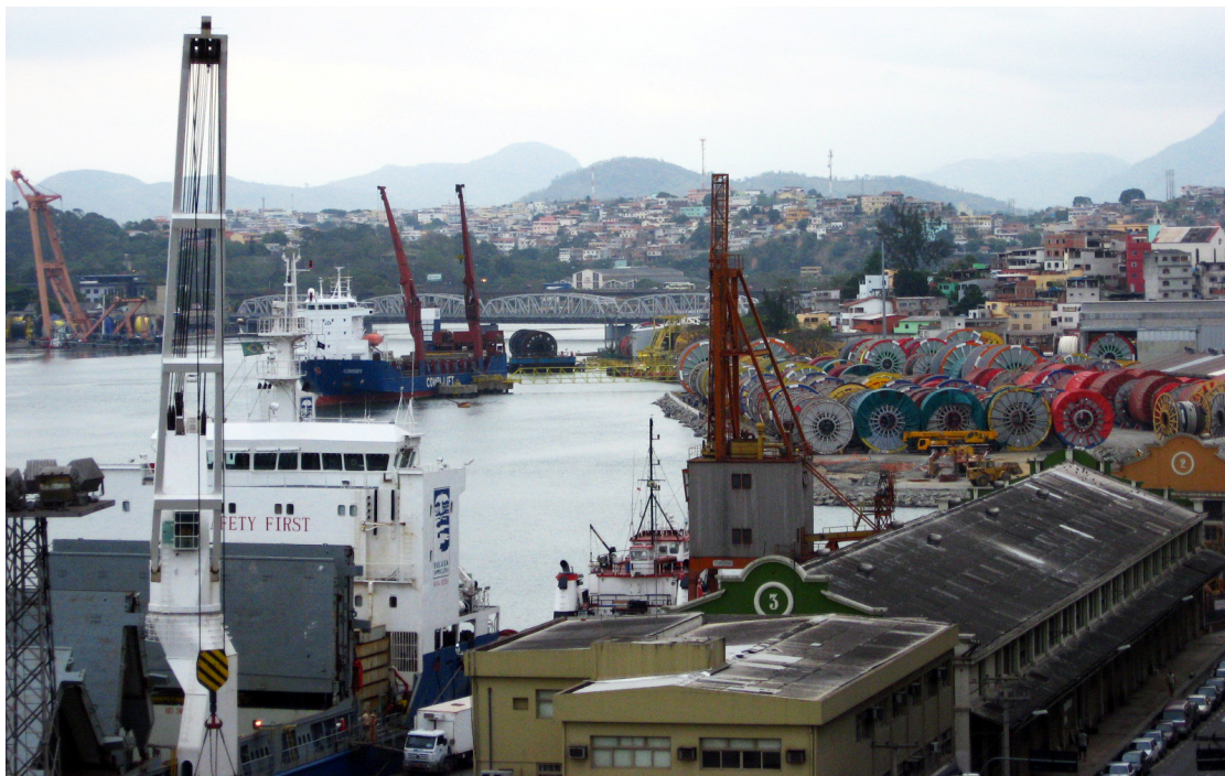
Figura 52 - Ao fundo: cais e pátio da empresa Flexibrás. Em primeiro plano: região do antigo Cais do Imperador, Avenida Marechal Mascarenhas de Moraes em Vitória (2013).
