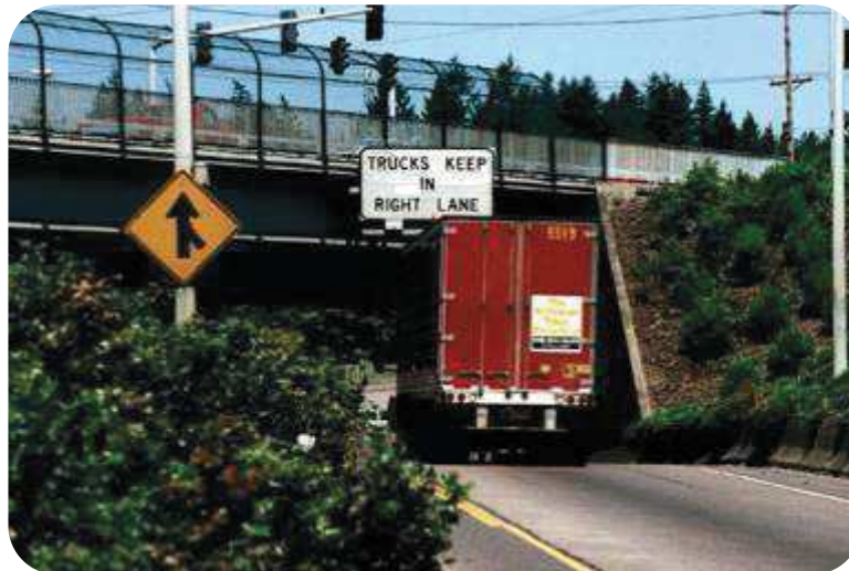
Figura 3.3 – Faixa exclusiva para veículos de carga em Oregon, Estados Unidos (Fonte: FORKENBROCK; MARCH, 2005)
