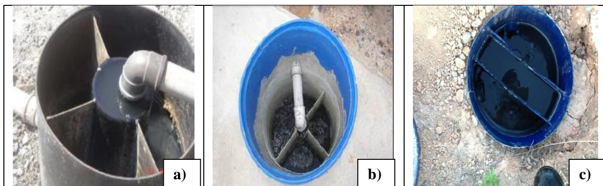
Figura 5.5. Diferentes compartimentos de distribuição utilizados nos SACs-EHSS, estando a nova configuração apresentada em c.
