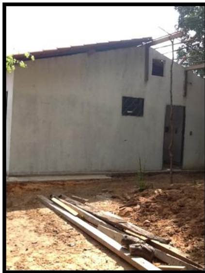
Figura 7: Casa do Edmar em construção. Fonte: Acervo da pesquisadora.
