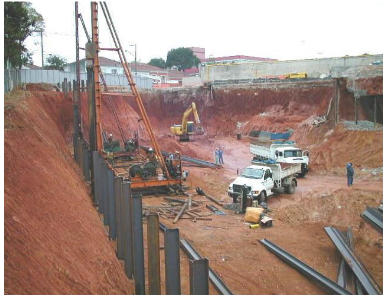
Figura 15 – Imagem da cravação de uma cortina formada por estacas metálicas Fonte: Notas de aula disciplina TEC I, UFMG, 2008.
