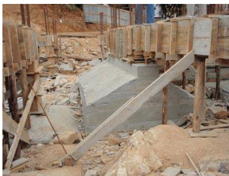
Figura 5 - Imagem de uma sapata associada em construção
