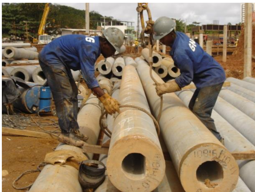
Figura 17 – Imagem de um conjunto de estaca premoldadas de concreto apresentando seção vazada Fonte: Fonte: Notas de aula disciplina TEC I, UFMG, 2008.
