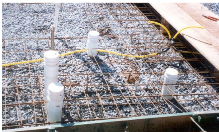
Figura 9 – Imagem das instalações hidro-sanitárias e elétricas no radier
