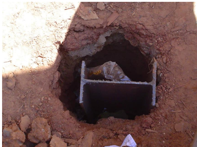
Figura 16 – Imagem de uma estaca metálica se seção I, após ser cravada Fonte: Arquivo pessoal, 2013.
