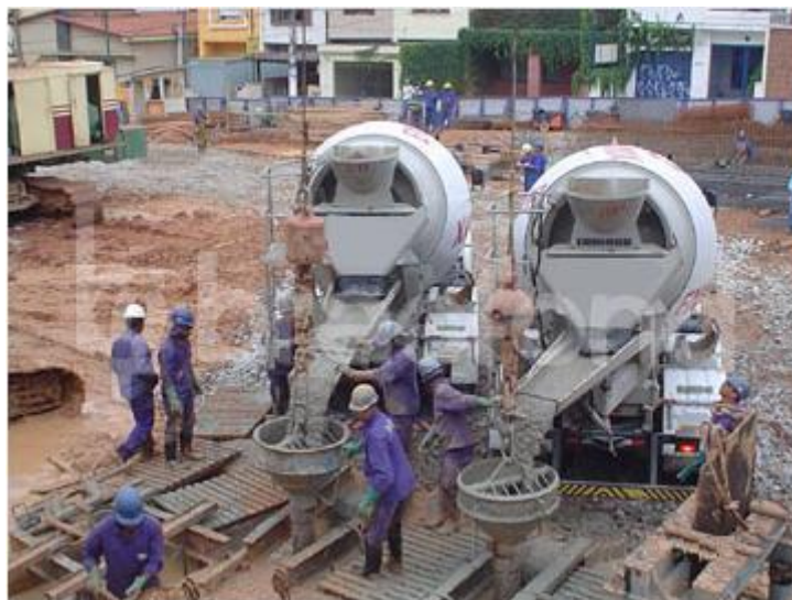
Figura 31 – Imagem da execução de uma concretagem submersa
