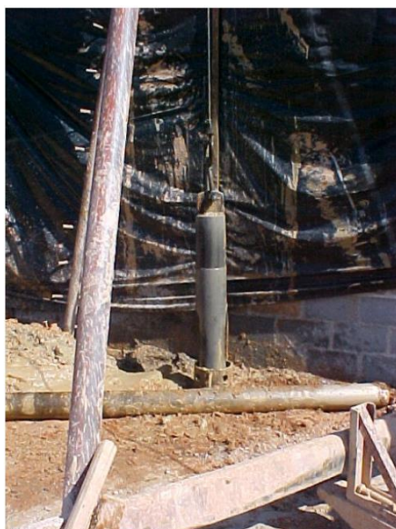
Figura 23 – Imagem da sonda de percussão na confecção da Estaca Strauss Fonte: Notas de aula disciplina TEC I, UFMG, 2008.
