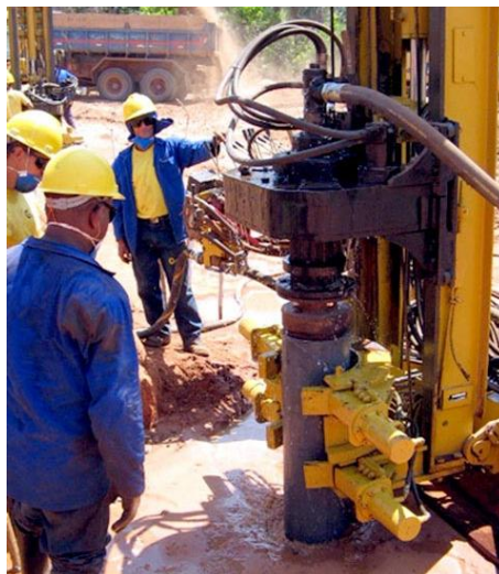
Figura 32 – Equipamento empregado na perfuração da Estaca Raiz Fonte: www.exatafundacoes.com.br/serv_er.php , Acesso junho 2014.
