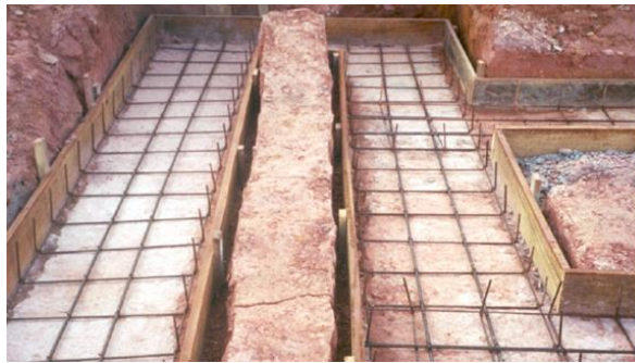
Figura 4 – Imagem da execução de uma Sapata Corrida em concreto armado
