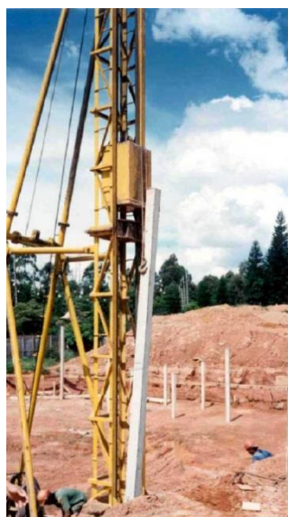
Figura 19 – Imagem de um bate-estaca que utiliza martelo de queda livre Fonte: Notas de aula disciplina TEC I, UFMG, 2008.
