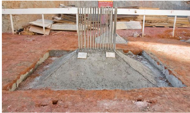
Figura 3 - Imagem de uma sapata isolada
