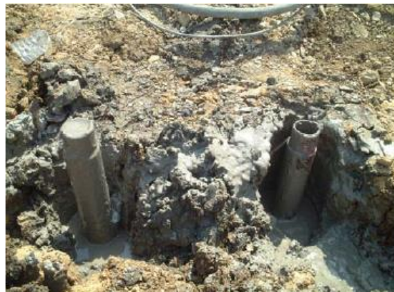
Figura 33 – Imagem de micro estacas preenchidas com calda de cimento Fonte: http://www.google.com.br/imagesmicroestacas , Acesso junho 2014.
