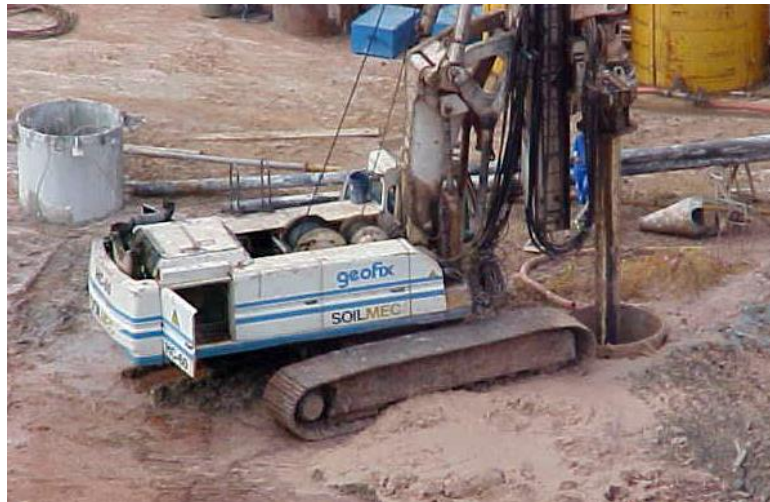
Figura 30 - Imagem do maquinário empregado na execução dos estações
