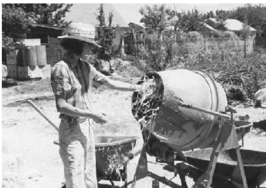
Figura 21- Utilização de betoneira para argamassa com fibras longas Fonte: HUNTER E KIFFMEYER, 2004.
