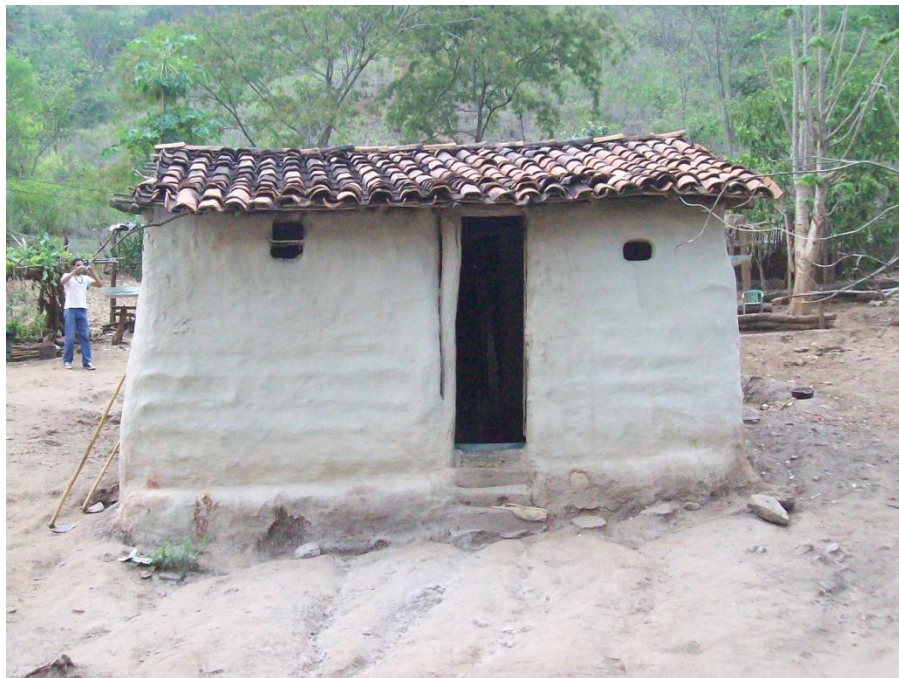
Figura 14- Habitação rudimentar construída em pau-a-pique com madeira retirada da mata próxima. Fonte: o autor.
