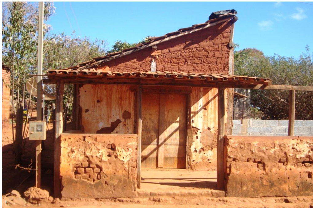
Figura 11- Edificação histórica parcialmente demolida para a construção de casa de alvenaria estrutural. Fonte: o autor
