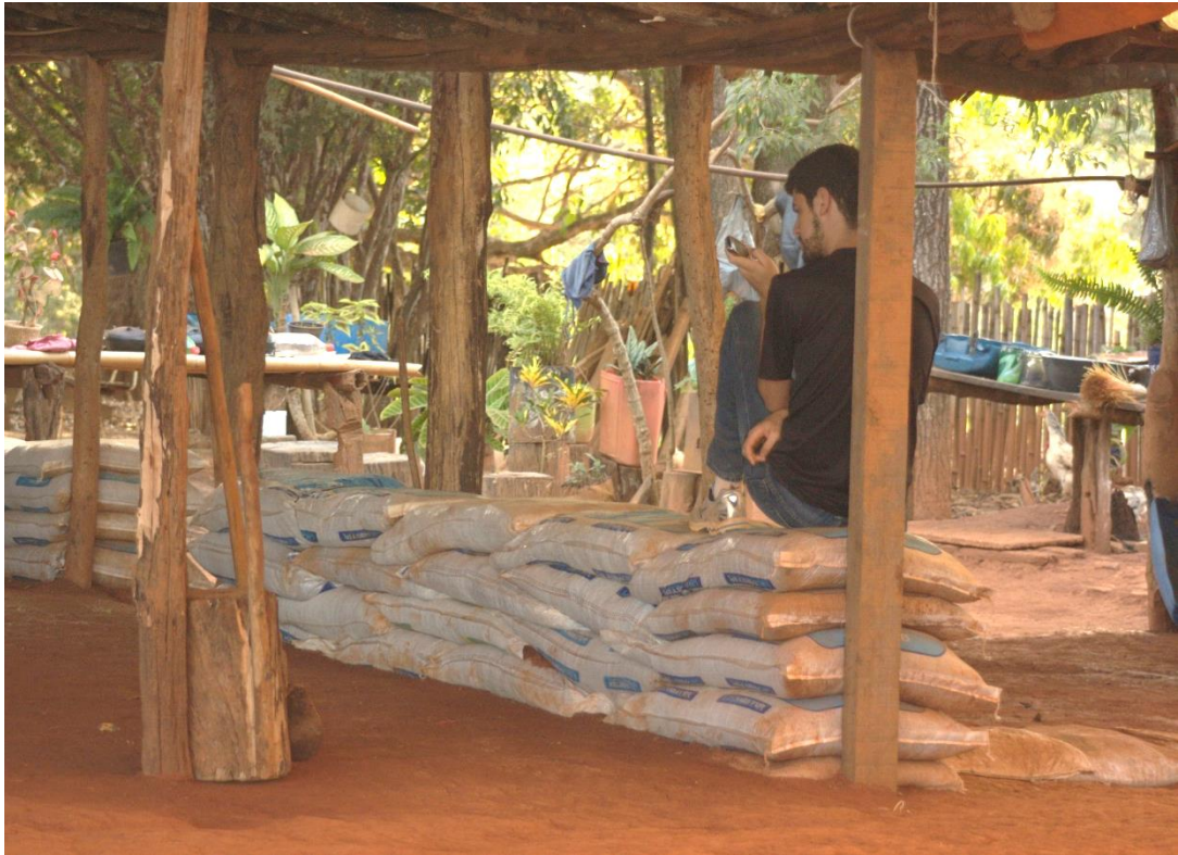
Figura 20- Tentativa de construção de parede em Superadobe. Fonte: o autor.
