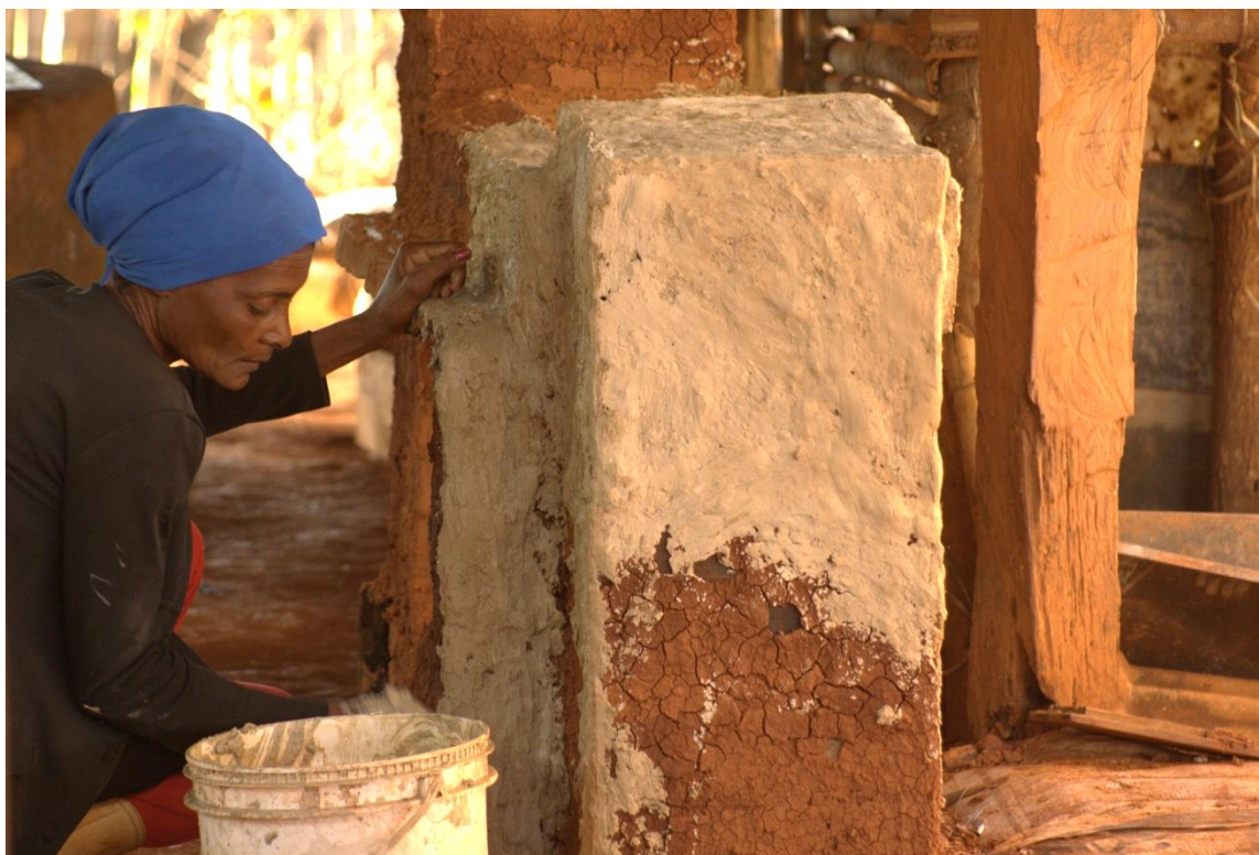
Figura 15- Aplicação de revestimento de tabatinga. Fonte: o autor.
