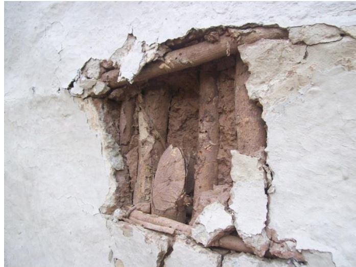
Figura 13- Detalhe da trama de madeira e acabamento em tabatinga. Fonte: o autor.
