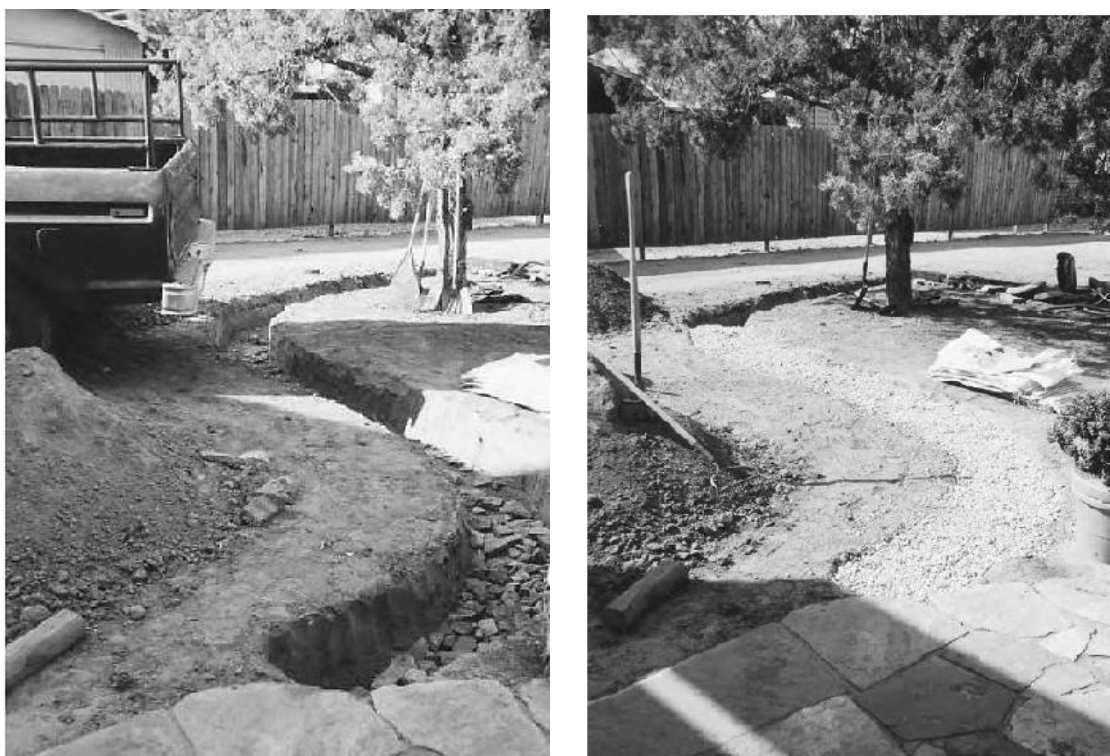
Figura 9 – Trincheira para fundação sem e com brita, respectivamente Fonte: HUNTER E KIFFMEYER, 2004.
