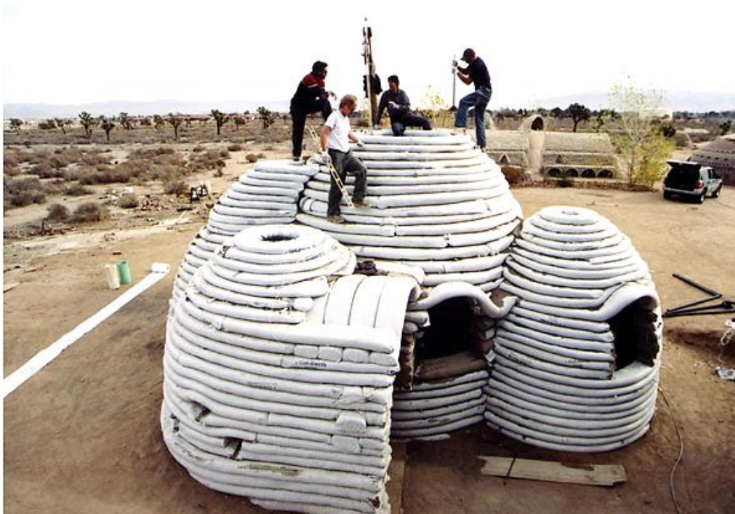
Figura 7 – exemplo de construção em Superadobe Fonte: CAL-EARTH, 2015.
