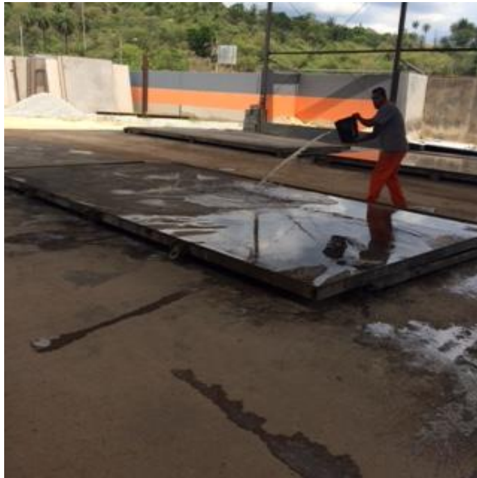
Figura 24 – Umedecimento do painel para atingir resistência. Fonte: Acervo do autor.
