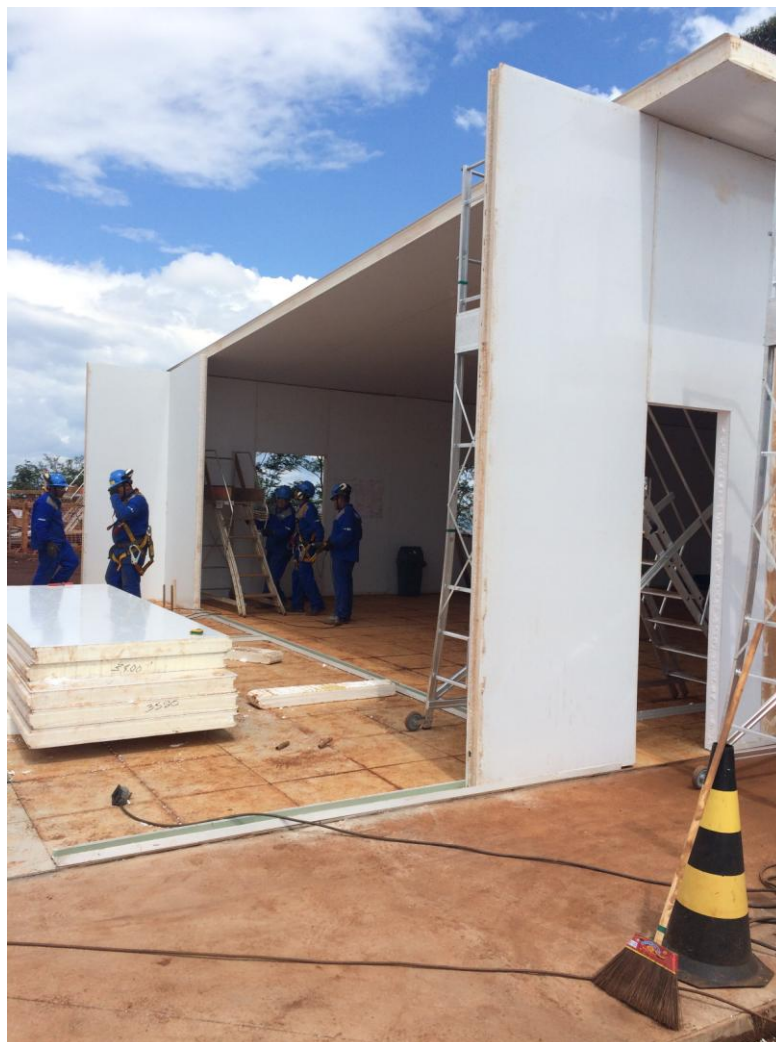
Figura 15 – Montagem de painéis PETI com perfis guia. Fonte: Acervo do Autor.
