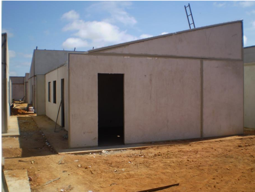
Figura 21 – Montagem em Concreto Laminar com diferentes alturas. Fonte: Laminus Engenharia.
