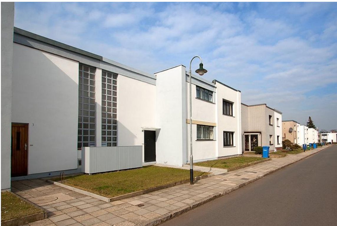
Figura 7 – Rua com casas no conjunto Torton. Fonte: Bauhaus (2000)
