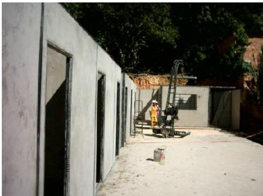
Figura 20 – Montagem de Edificação em Concreto Laminar. Fonte: Laminus Engenharia.
