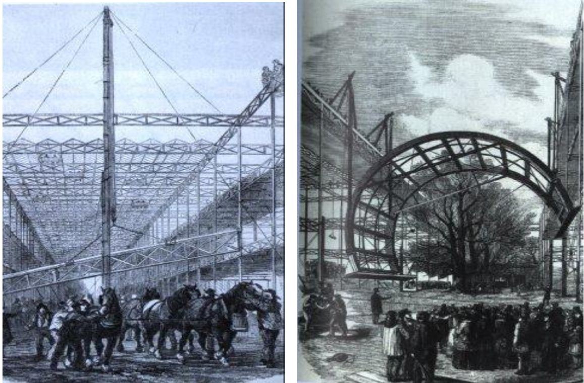
Figura 5 – Montagem da Estrutura metálica do Palácio. Fonte: Laboratório de Mecânica Computacional (2007)
