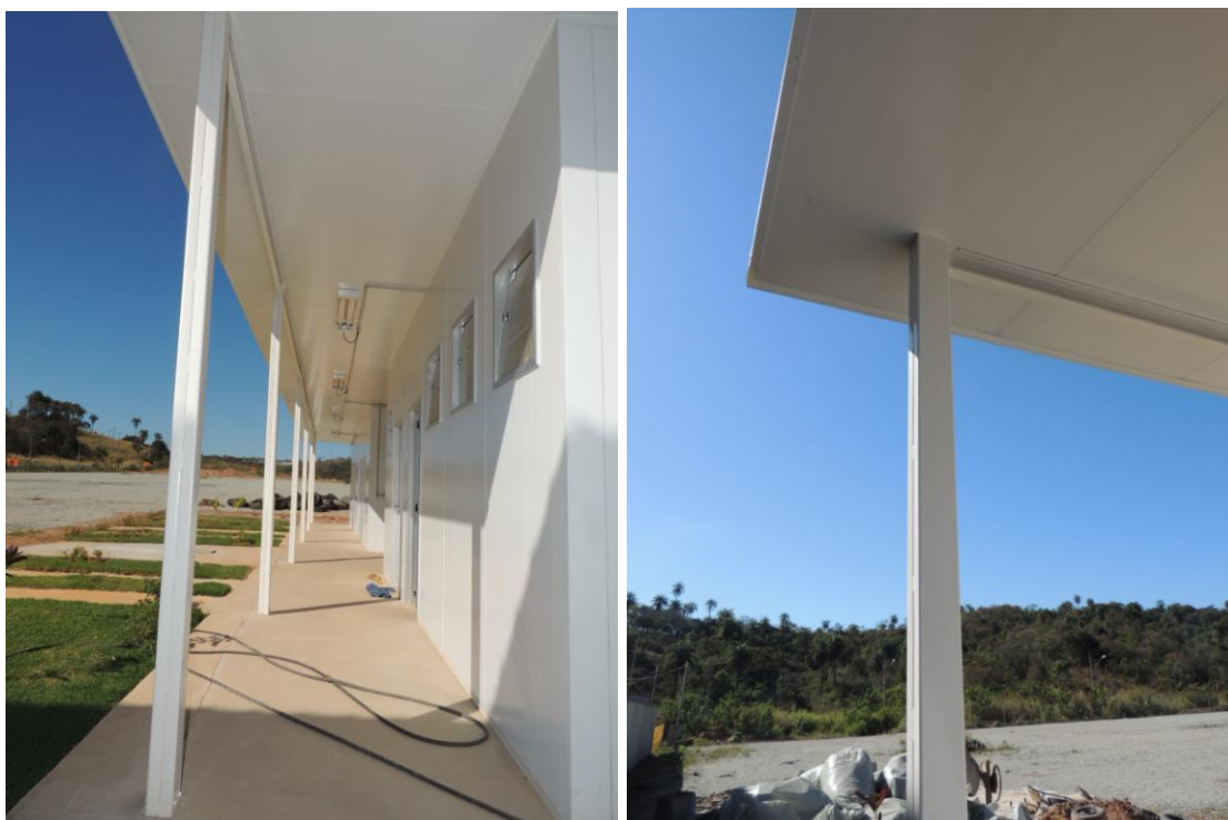
Figura 19 – Estruturas metálicas complementares. Fonte: Acervo do autor.
