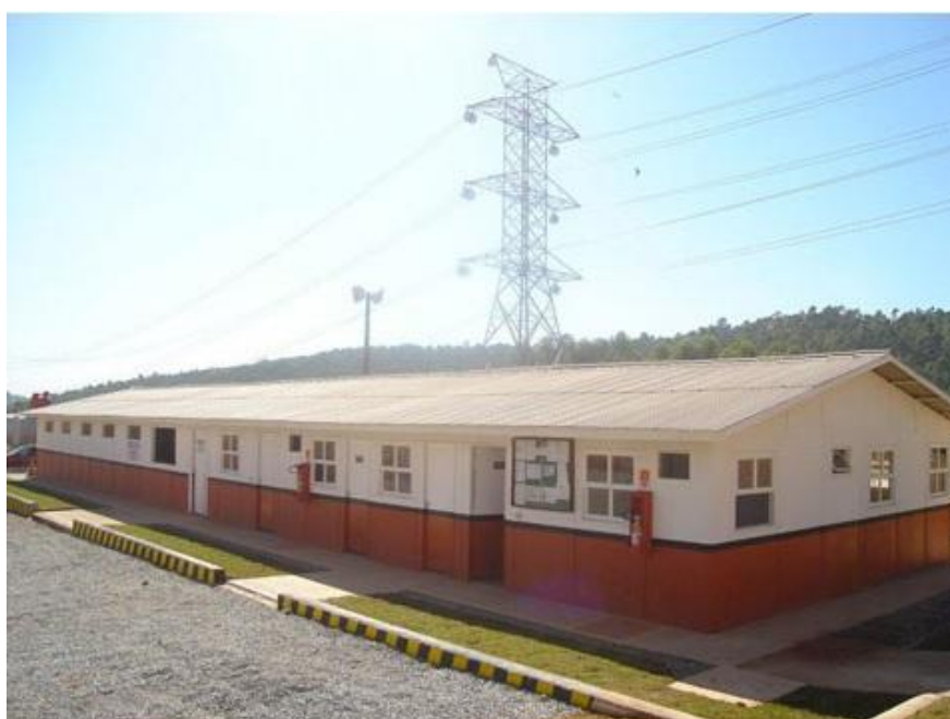
Figura 27 – Escritório de obras em OSB. Fonte: Melo Canteiros.
