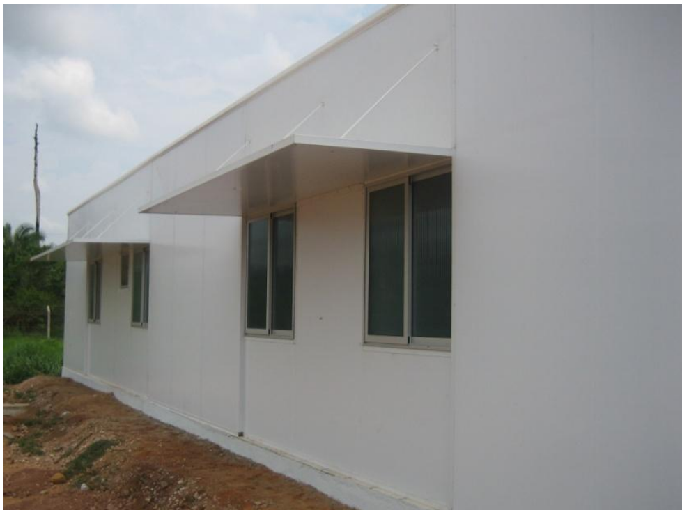
Figura 16 – Escritório para mineradora em painel PETI. Fonte: Acervo do Autor
