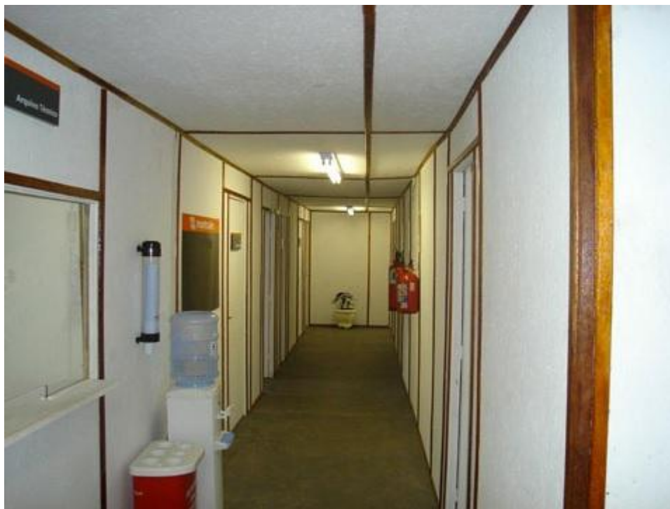
Figura 31 - Escritório com forro em OSB. Fonte: Melo Canteiros
