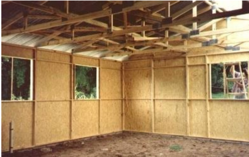
Figura 30 - Construção em OSB com estrutura de telhado em madeira. Fonte: LP Brasil.
