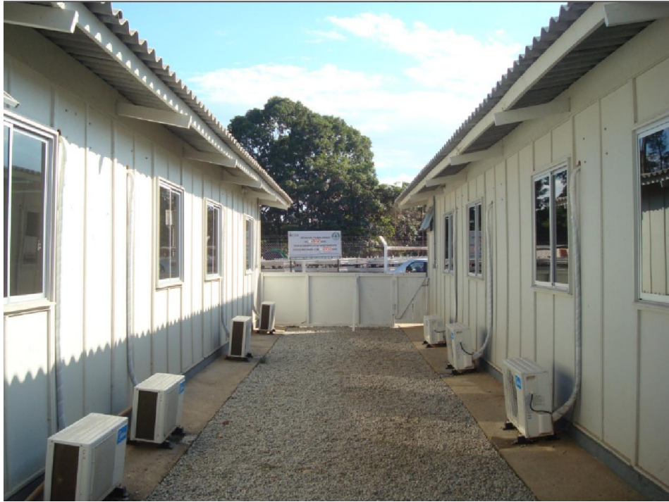
Figura 29 - Detalhe externo do canteiro da Cimcop em OSB. Fonte: Costa(2012)
