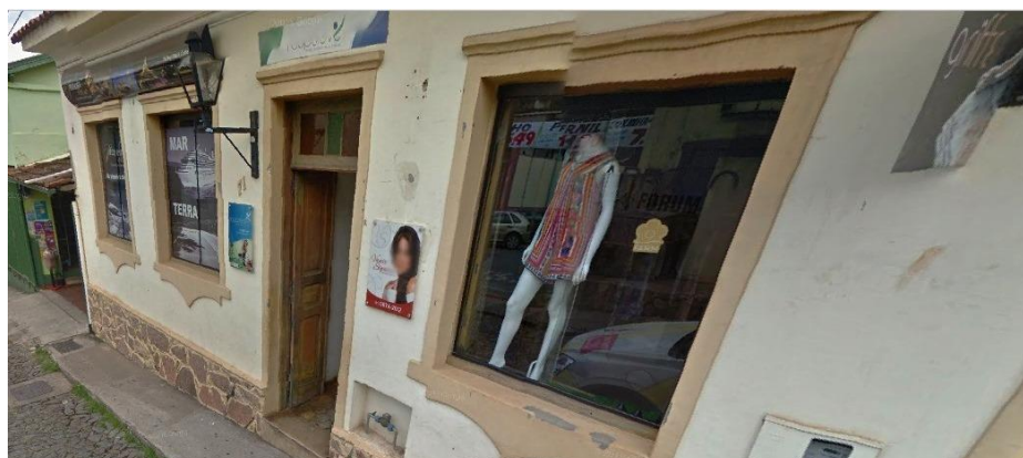
Foto 27 – Imóvel tombado Rua São Pedro nº 74
