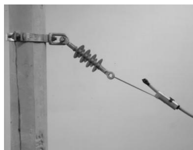
(b) Montagem com cabo coberto
