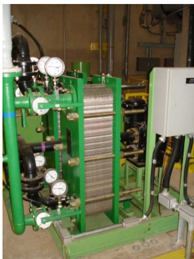
Figura 3.18 - Bombas do mancal de escora.
