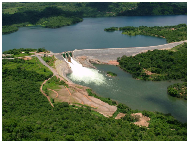
Figura 3.46 - Estrutura civil do vertedouro.
