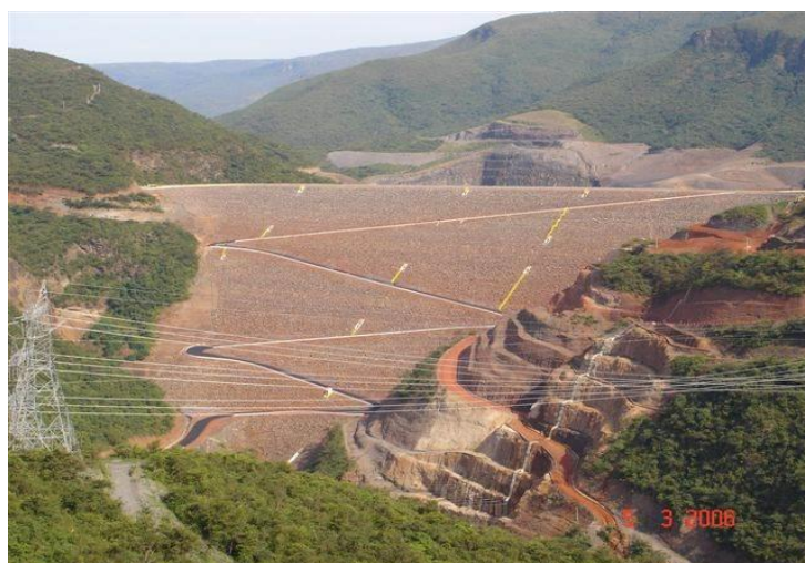
Figura 3.5: Barragem de Irapé concluída. Fonte: CEMIG, 2006
