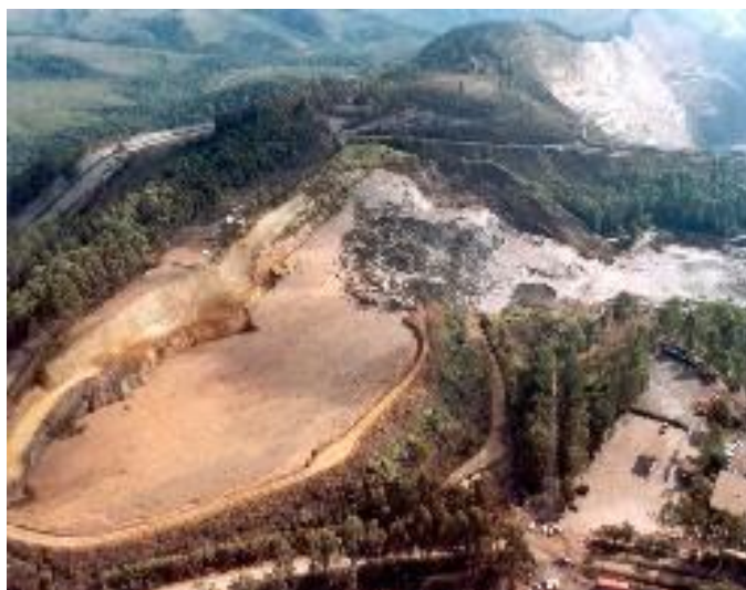
Figura 2.15: Vista aérea da Barragem da Mineração Rio Verde. Fonte: Precisão Consultoria, 2014.
