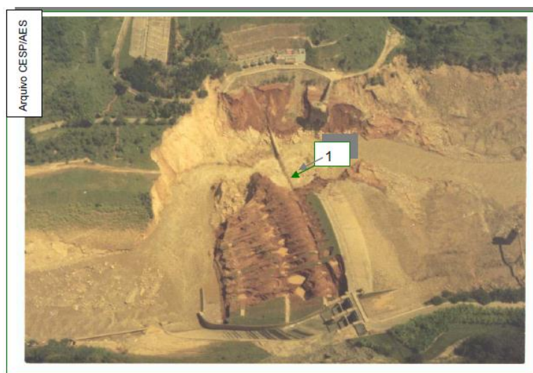
Figura 2.14: Barragem Euclides da Cunha - Situação do maciço após ruptura por galgamento (1977). 1 - Galeria do Cut off. Fonte: Cardia, 2007.
