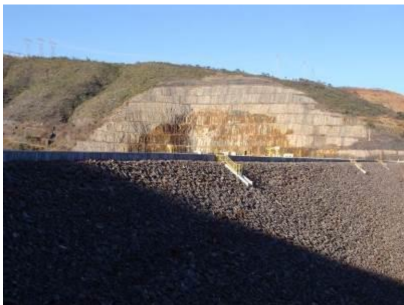
Figura 3.9: Vista do corte da tomada d'água/vertedouro. Fonte: CEMIG, 2014
