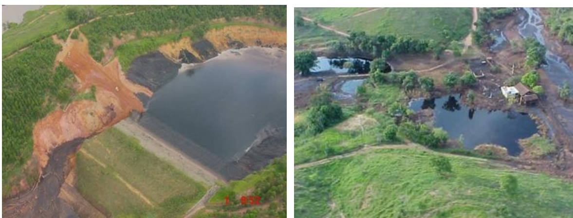
Figura 2.16: Imagem aérea da barragem de Cataguases e do ribeirão do Cágado, após a ruptura. Fonte: Vianna, 2012.
