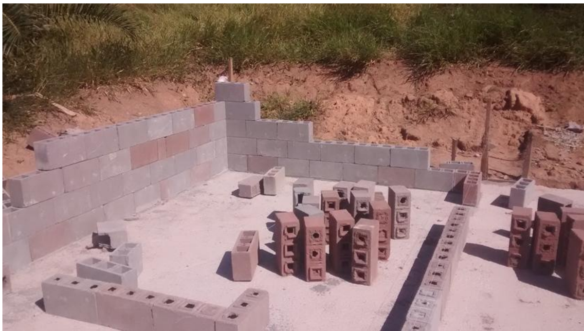
Figura 07 – Início da obra em Pedro Leopoldo
