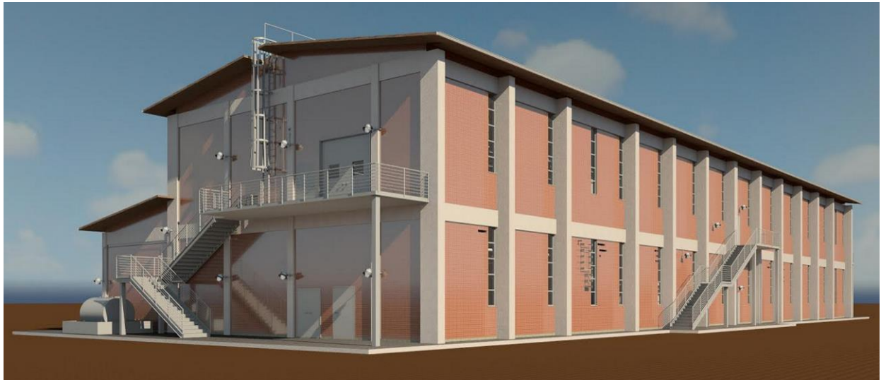
Figura 53 – Sala Elétrica industrial modelada no Revit Architecture e dimensionada pelos softwares Robot e SAP 2000. Imagem Fotorrealística criada na ferramenta Rendering do Navisworks
