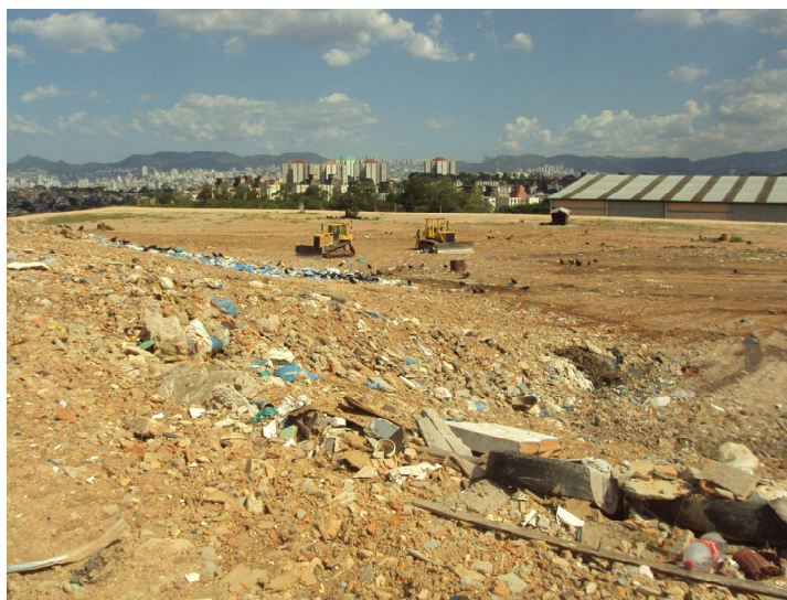
Figura 9: Vista parcial do aterro de resíduos hospitalares.
