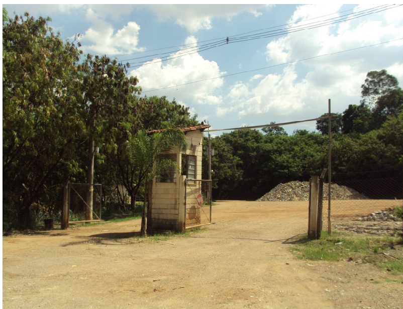
Figura 7: Portaria de acesso à Usina da BR-040, guarita, cano superior de aspersão de água e pátio de recepção e triagem.
