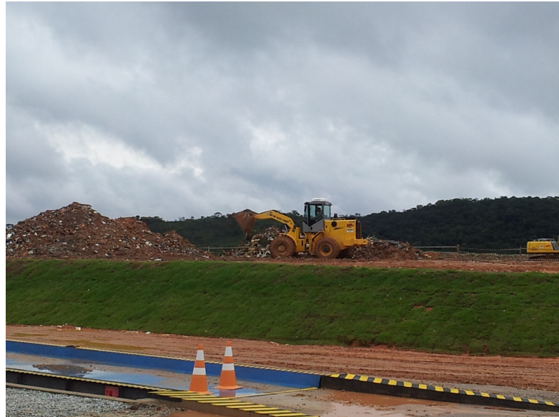
Figura 5: Vista parcial do aterro de Maquiné, pátio de descarga de entulho.
