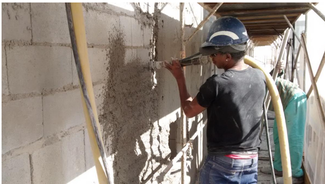
Figura 06 – Aplicação da argamassa projetada
