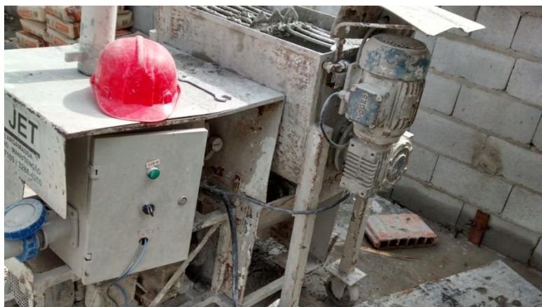
Figura 04 – Máquina utilizada para projeção do reboco
