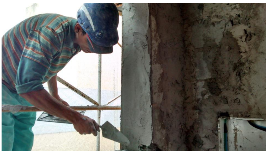
Figura 03 – Pedreiro fazendo acabamento em janela
