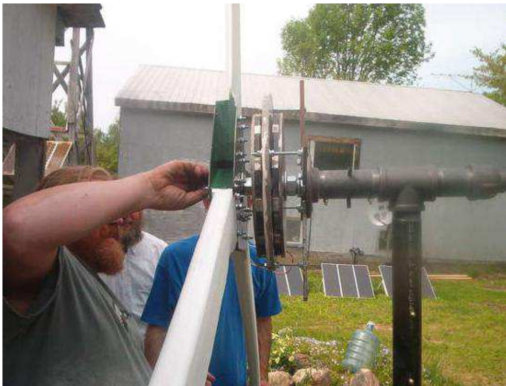
Figura 2.10- Aerogerador em construção [Portal, 2015].
