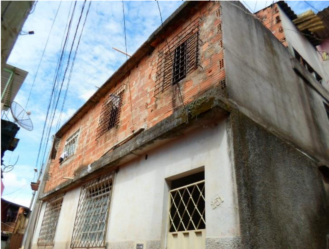
Figura 11 - Fachada - Existem duas unidades no mesmo terreno, porém o levantamento é apenas da unidade que ocupa o 2º pavimento.
