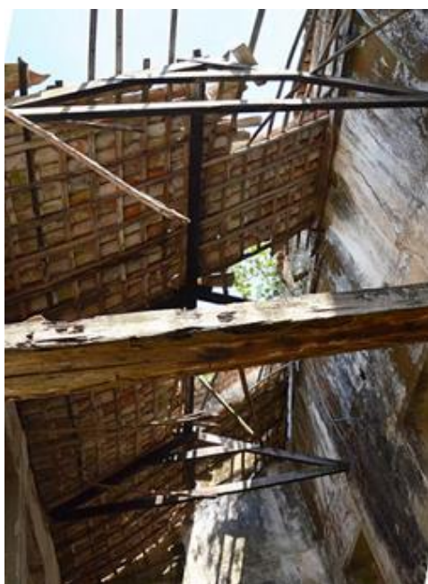
Figuras 55 e 56 – Detalhes das Coberturas Danificadas: Corredor Lateral e Nave Fonte: Acervo da autora, 2012
