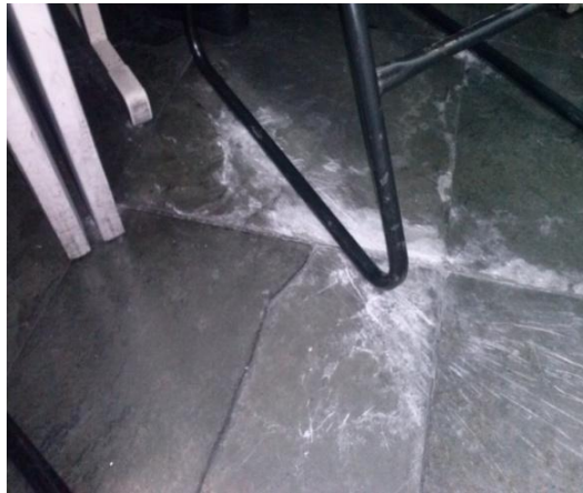
Figura 4: Aspecto do piso na época da análise
