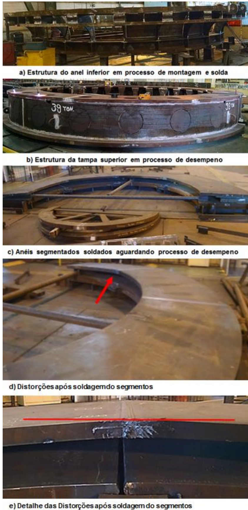
FIGURA 1.3 - Estruturas e anéis segmentados em processo de fabricação – cortesia DELP.
