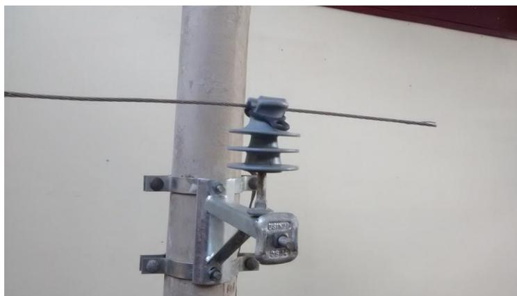
Figura 4.19 Estrutura CM2 ensaiada na presença do cabo nu.
