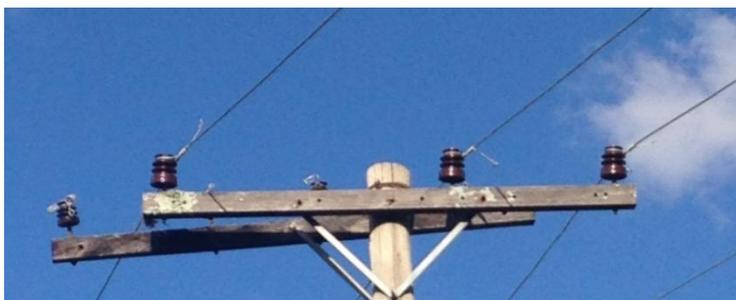
Figura 1.1 Isolador tipo pino em uma rede de distribuição convencional.
