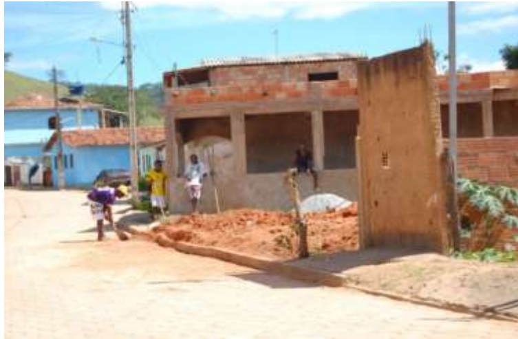
Foto 5: Novas construções na Comunidade de Barro Preto
