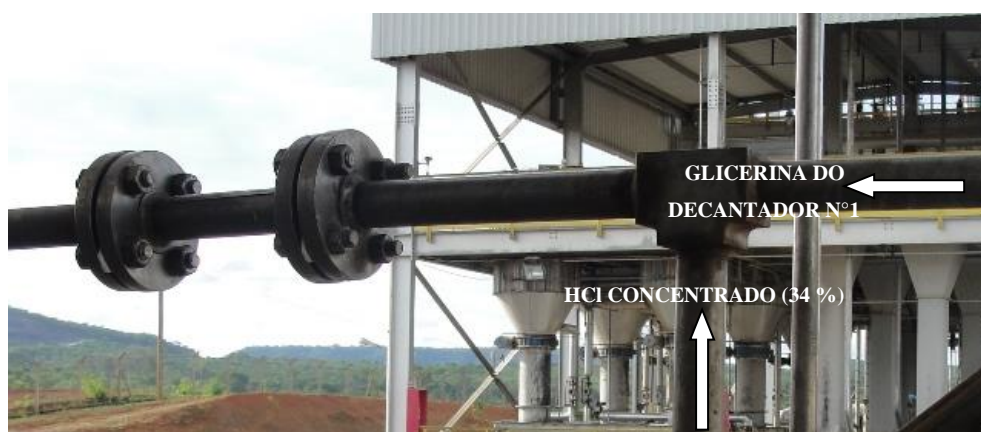
Figura 6- Ponto de dosagem de ácido clorídrico na corrente de glicerina (TORRES, 2013).
