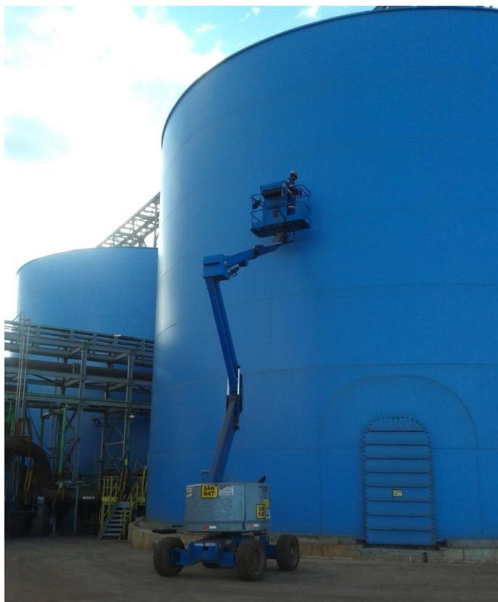
FIGURA 4.18. Medição das espessuras do Tanque de Concentrado com auxílio da plataforma articulada.
