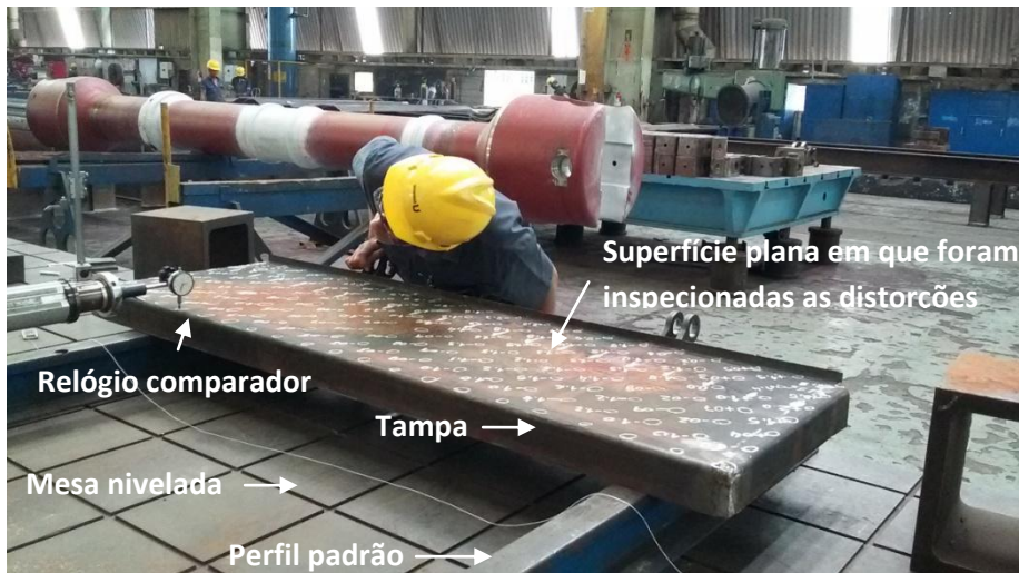
Figura 3.25 - Inspeção da planicidade na superfície da tampa.
