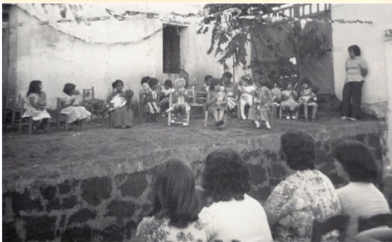
Figura nº 1 e 2- pátio interno do Jardim da Infância-década 1970
