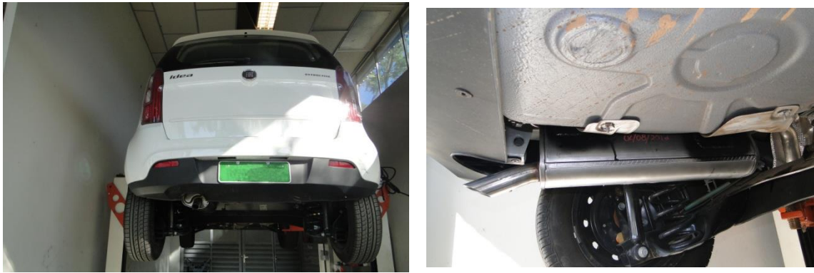
FIGURA 3.20 – Montagem do abafador de ruído preparado com adsorvente natural ZN 2040.
