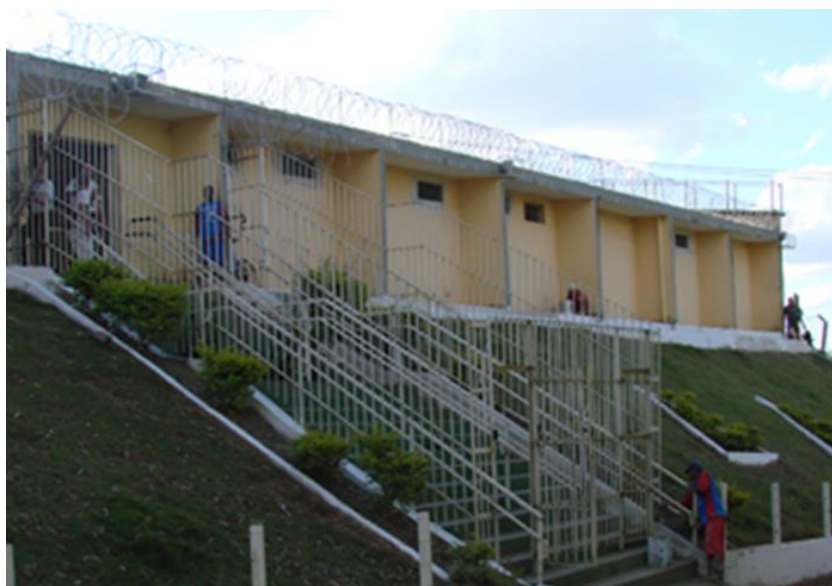
Figura 1: Entrada do Prédio
