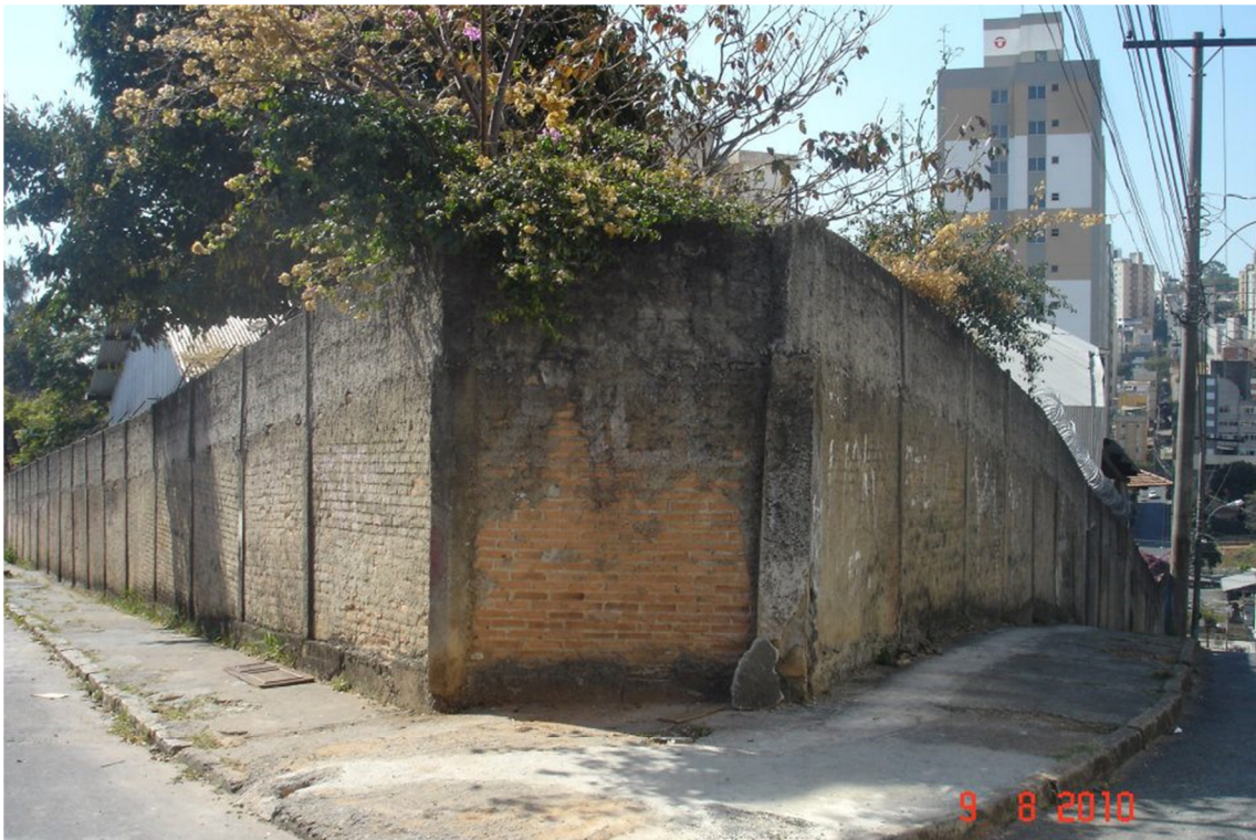
Figura 8 - Projeto Dos Muros Sai Vida – Etapa final.
