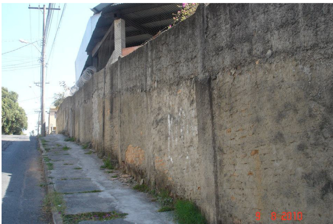
Figura 7 – Projeto Dos Muros Sai Vida – Etapa final.
