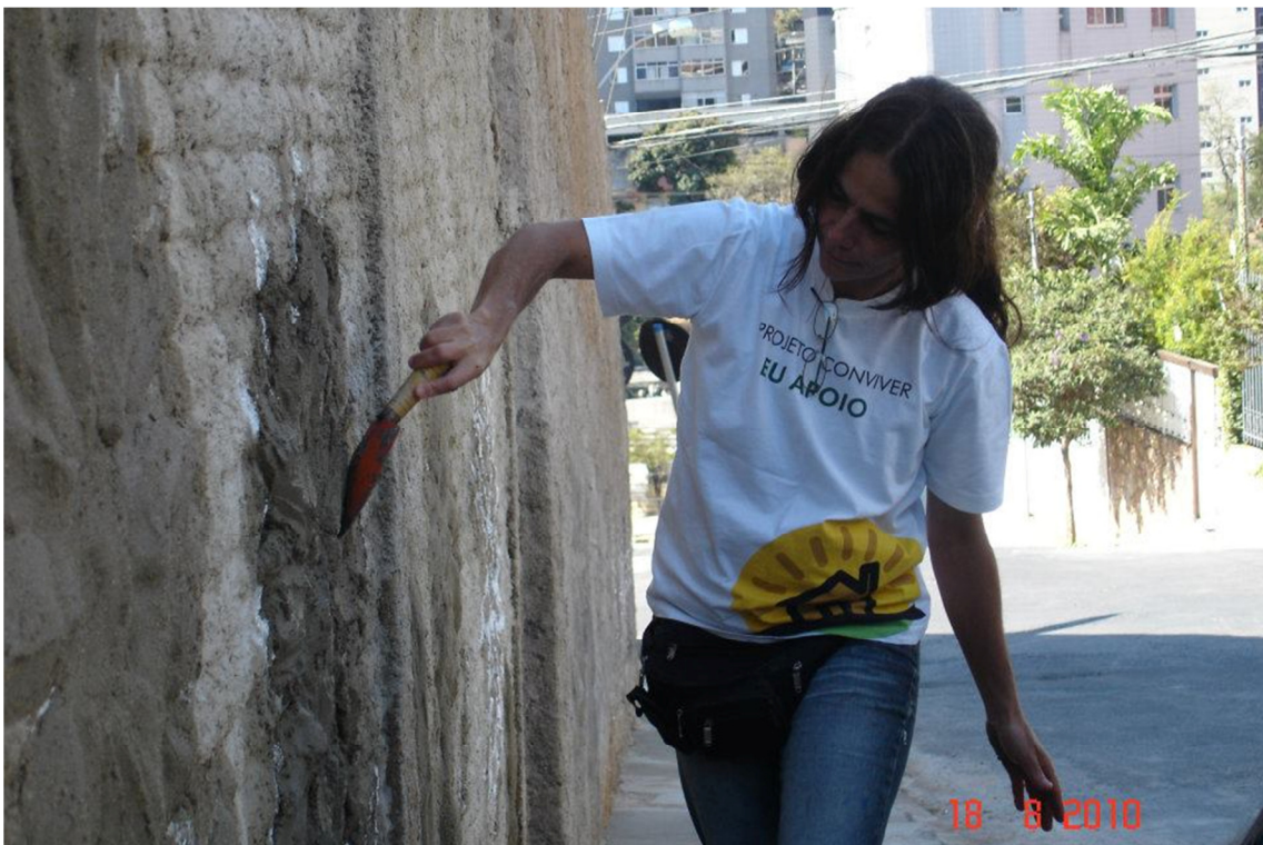
Figura 8 - Projeto Dos Muros Sai Vida – Etapa final.
