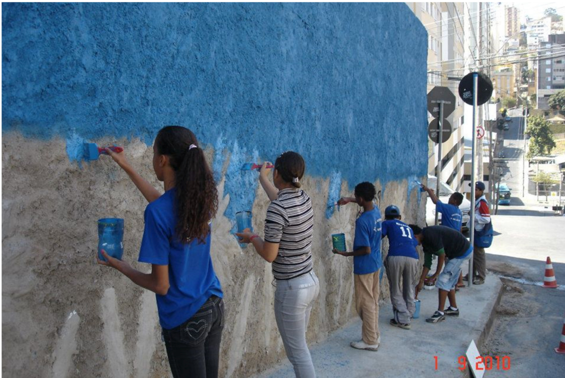
Figura 12 - Projeto Dos Muros Sai Vida – Etapa final.
