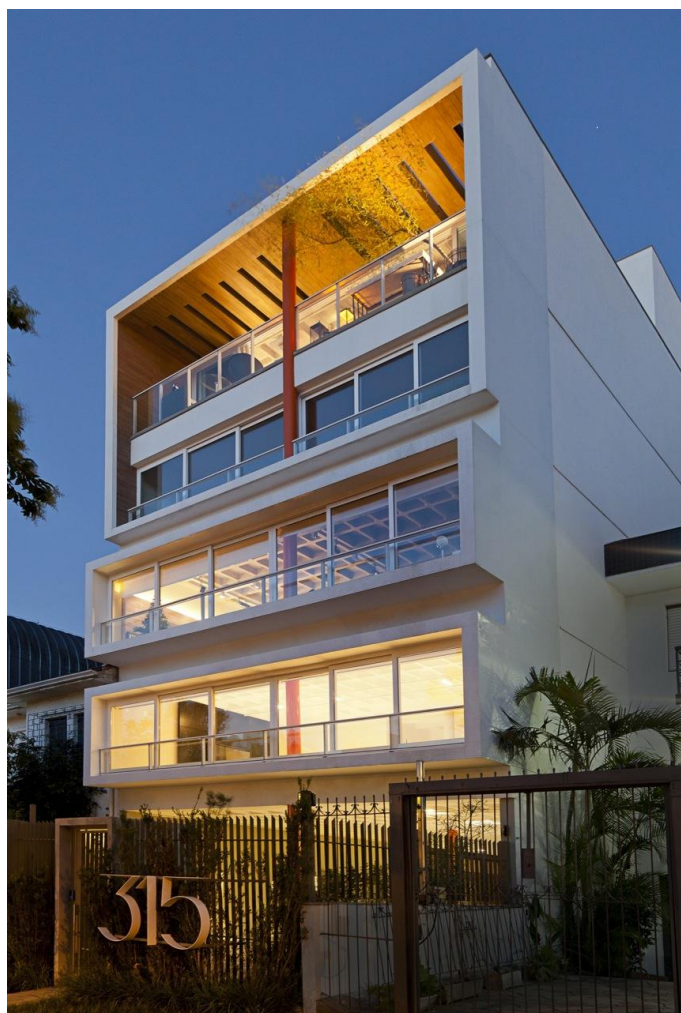
Figura 12 – Edifício Amélia Teles – Smart! - Porto Alegre RS – Brasil. Edifício Residencial composto por apartamentos com planta livre, sem vigas, fruto do uso de lajes nervuradas, completamente personalizável e segundo seus autores, adaptável ao seu morador - Fonte: Archdaily
