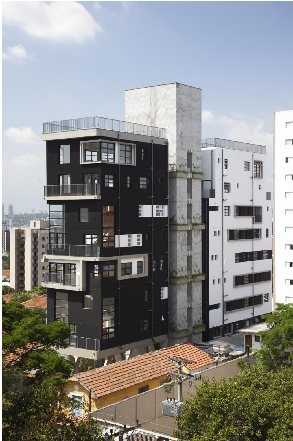
Figura 16 – Edifício Fidalga 727 – Triptyque – São Paulo SP – Brasil. Edifício Residencial composto por apartamentos com planta livre que permitem diferentes divisões internas – modulação hidráulica e distribuição elétrica electrical plugs distribution - Fonte: Archdaily
