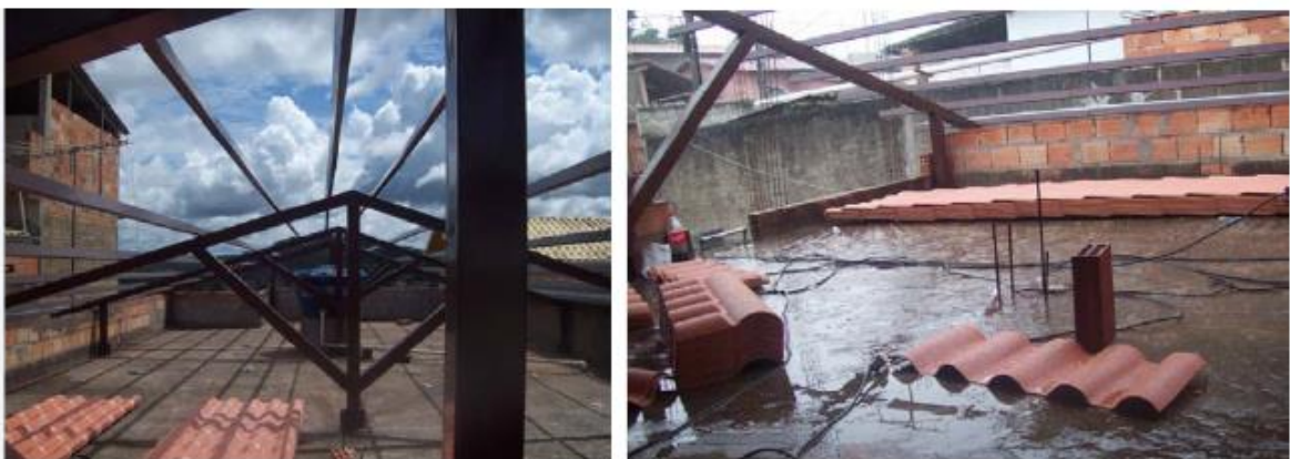
Figura 1.6- Armazenamento das telhas e das cumeeiras em obra
