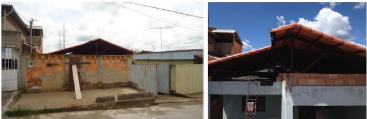
Figura 1.14 - Vista frontal da edificação térrea unifamiliar
