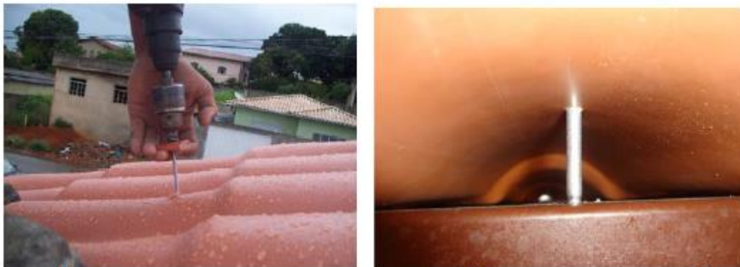
Figura 1.10- Furação e fixação da telha no perfil metálico
