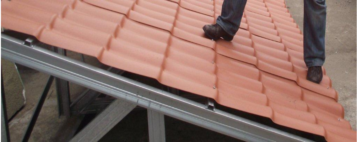
Foto 7: Detalhe Telha Perfil Colonial cor Cerâmica
