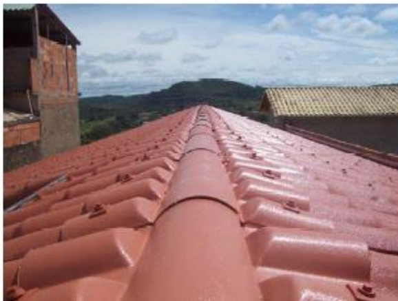
(a) Face externa do telhado
