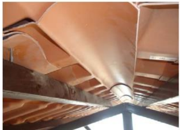
(b) Face interna do telhado
