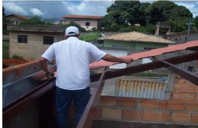
Figura 1.9 - Fotografia de instalação da primeira telha
