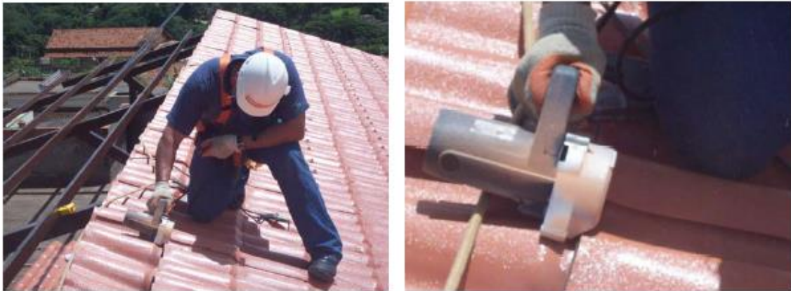
Figura 1.13 - Corte da telha próximo a cumeeira
