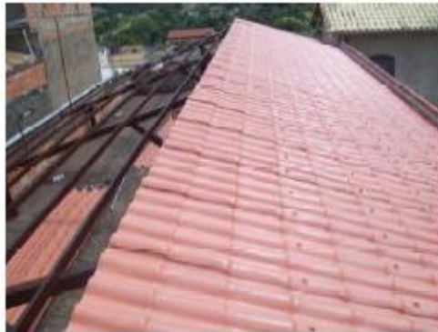
Figura 1.11- Montagem de uma água do telhado
