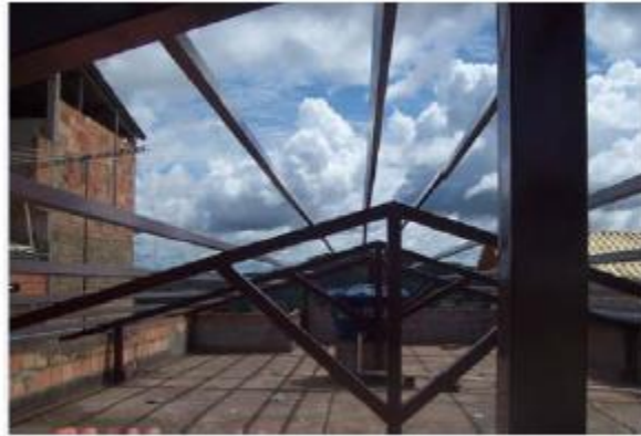
Figura 1.7- Estrutura de telhado em perfis metálicos
