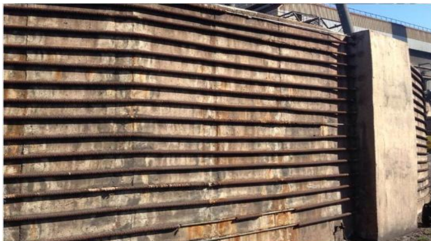
Figura 3.16 – Protensão externa de tanque industrial.
