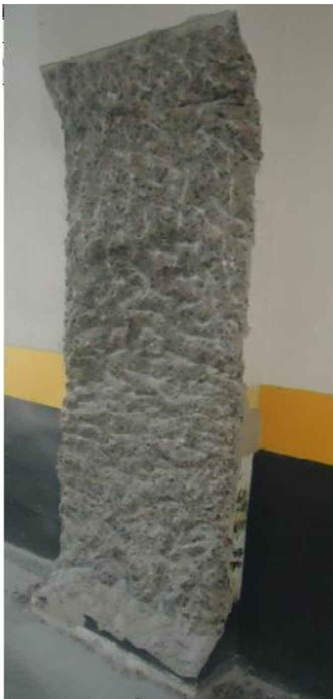
Figura 4.4 – Demolição de parte da seção do pilar.
