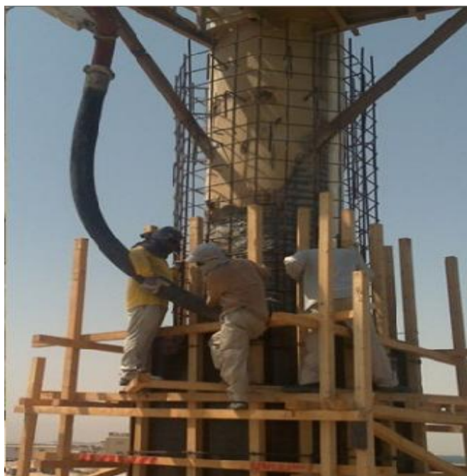
Figura 3.4 – Concretagem do encamisamento de outro pilar.
