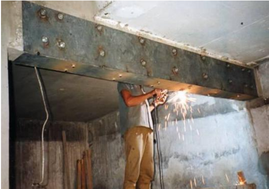
Figura 3.7 – Fixação de chapa metálica.
