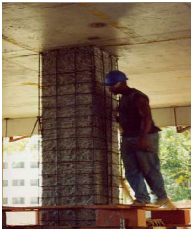
Figura 3.3 – Colocação da armação de reforço para o encamisamento do pilar.
