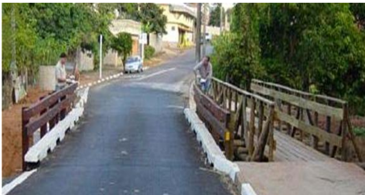
Figura 3.23 – Ponte concluída e em uso. Fonte: FONTE e CALIL JÚNIOR (2006).
