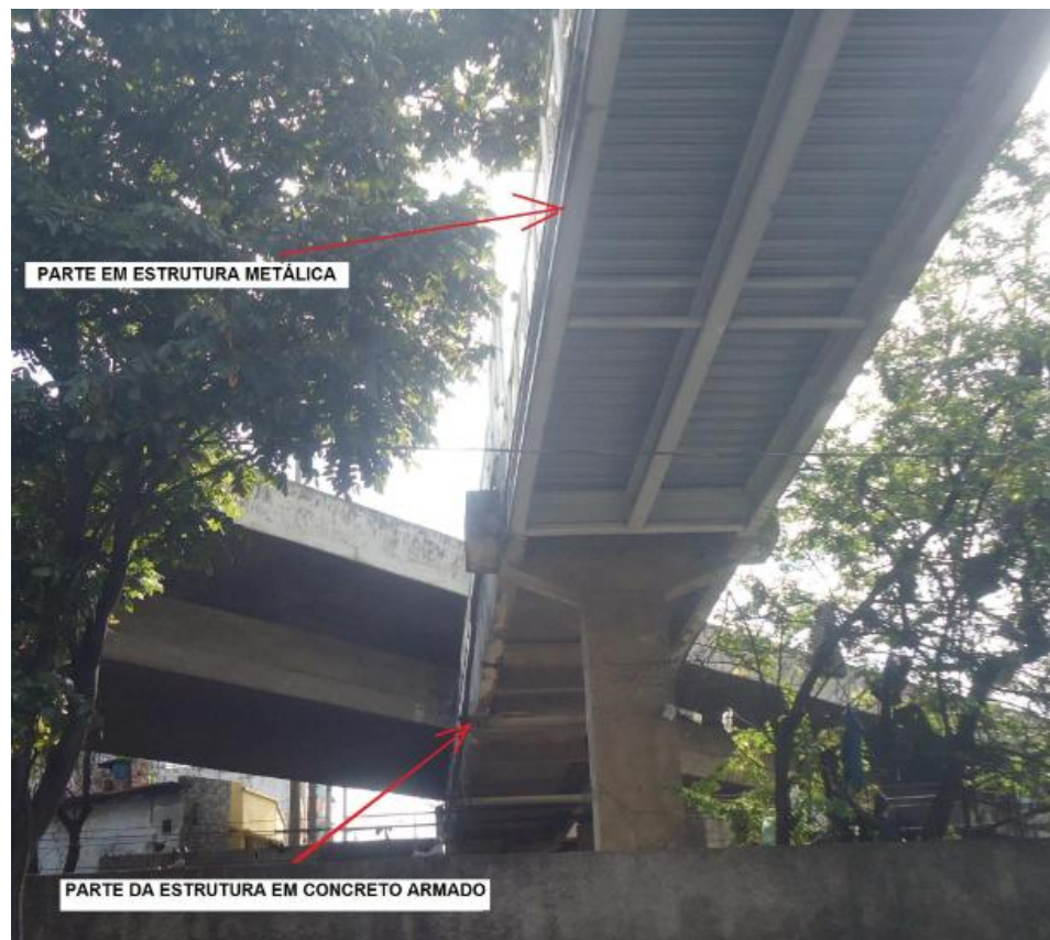
Figura 4.7 – Passarela em rua de Belo Horizonte: parte em concreto armado, parte em estrutura metálica.
