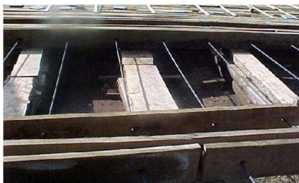
Figura. 3.20 – Construção e protensão da ponte.
