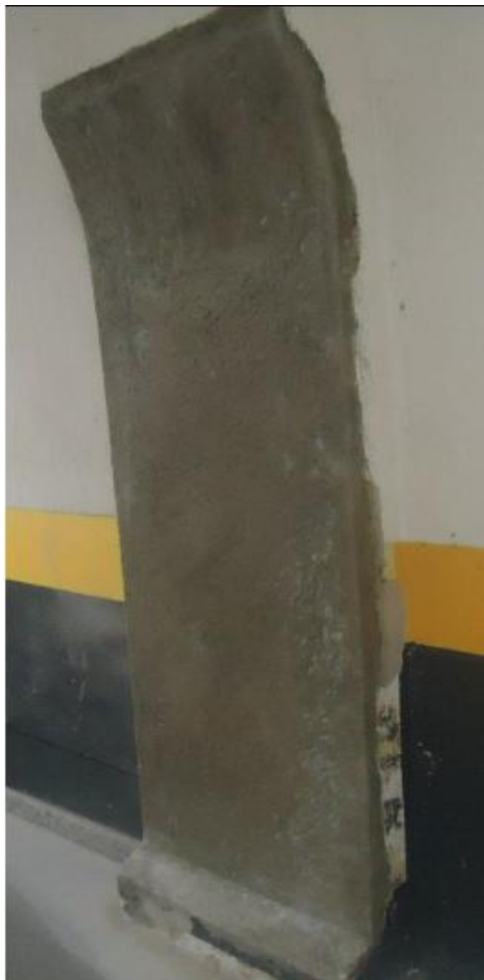
Figura 4.5 – Preparação e regularização da superfície do pilar.
