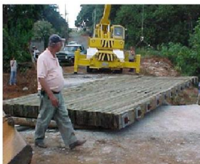
Figura 3.21 – Lançamento do tabuleiro da ponte de madeira.
