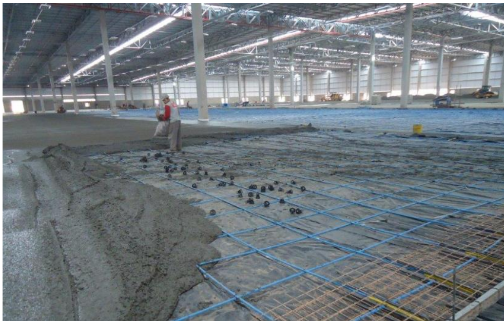
Figura 3.9 – Piso protendido em galpão industrial.
