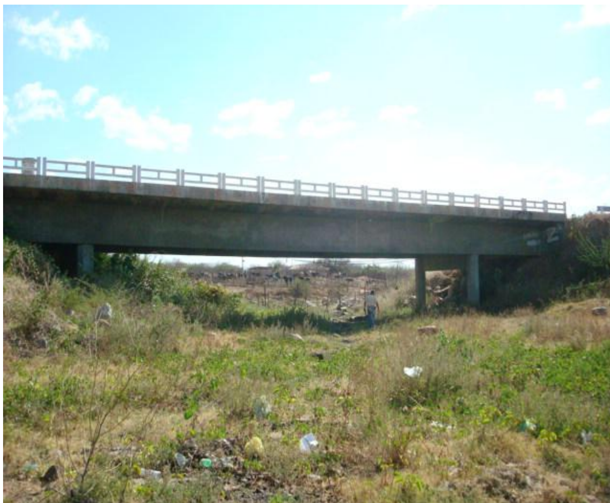
Figura 3.17 – Foto da ponte de referência (BR 316/PI).
