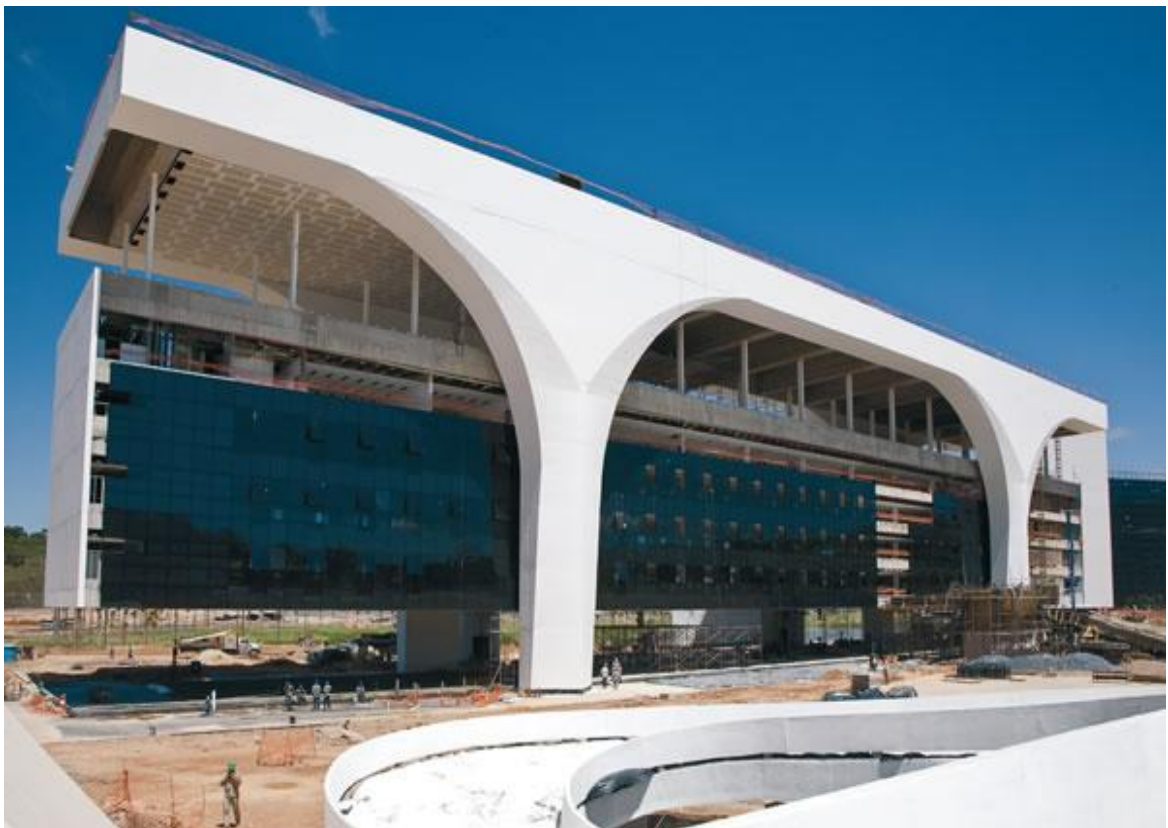
Figura 3.13 – Nova Sede Administrativa do Governo de Minas Gerais.
