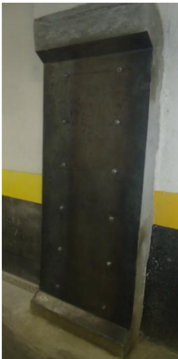
Figura 4.6 – Instalação da chapa metálica no pilar.
