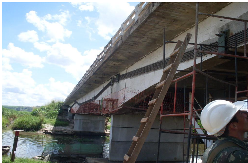
Figura 3.15 – Facilidade de inspeção visual do sistema protendido externamente.
