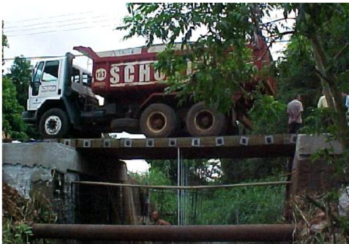
Figura 3.22 – Prova de carga da ponte de madeira.
