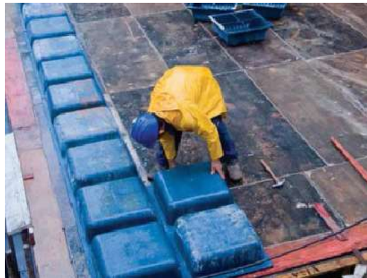
Figura 30: Cubeta distribuída lado a lado sobre painéis de compensado Fonte: http://construcaomercado.pini.com.br/
