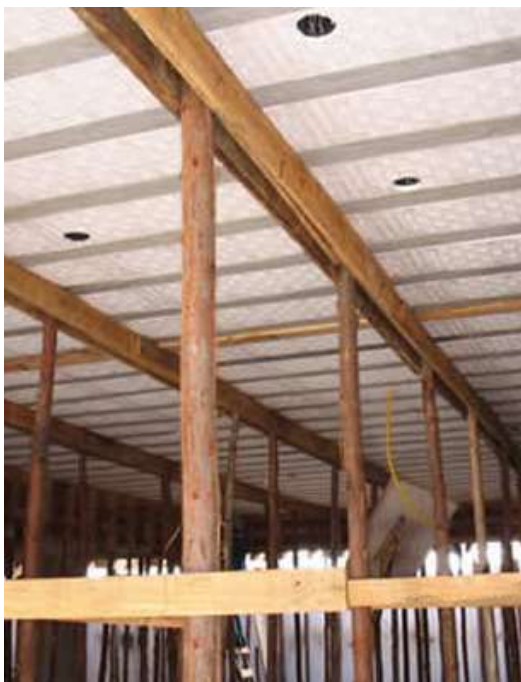
Figura 21: Escoramento de madeira de lajes treliçadas com preenchimento em EPS. Fonte: http://techne.pini.br
