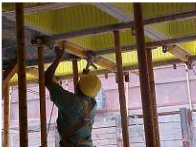
Figura 62: Processo de desmontagem do sistema Fonte: ULMA Construction
