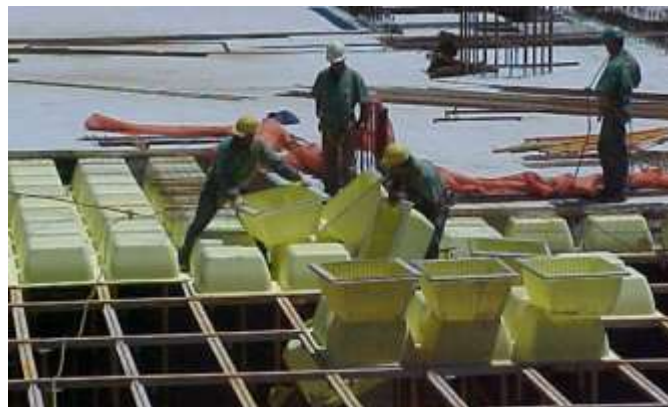
Figura 58: Colocação das cubetas na grelha metálica concluída Fonte: ULMA Construction
