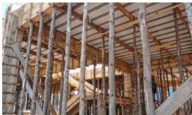
Figura 20: Escoramento de lajes e vigas utilizando madeira Fonte: http://techne.pini.br
