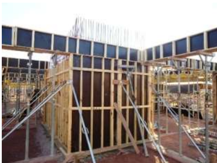
Figura 5: Utilização de compensados para fôrmas de paredes e vigas.
