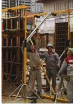
Figura 50: Montagem das transversais Fonte: ULMA Construction
