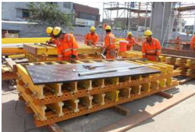
Figura 7: Preparação em obra da fôrma ENKONFORM, feita com vigas VM20 e compensado. Fonte: ULMA Construction
