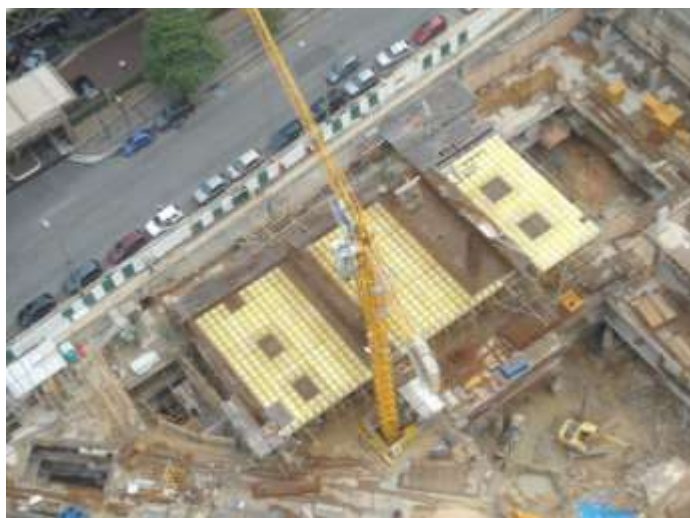
Figura 78: Edifício Forluz Fonte: ULMA Construction
