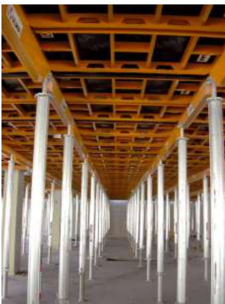
Figura 15: Fôrmas CC4 e escoramentos ALUPROP para lajes maciças Fonte: ULMA Construction
