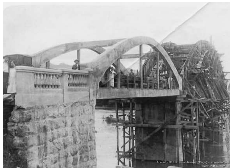
Figura 1: Ponte de concreto na cidade de Indaial – SC, utilizando fôrmas e escoramentos de madeira Fonte: http://www.indaial.com.br
