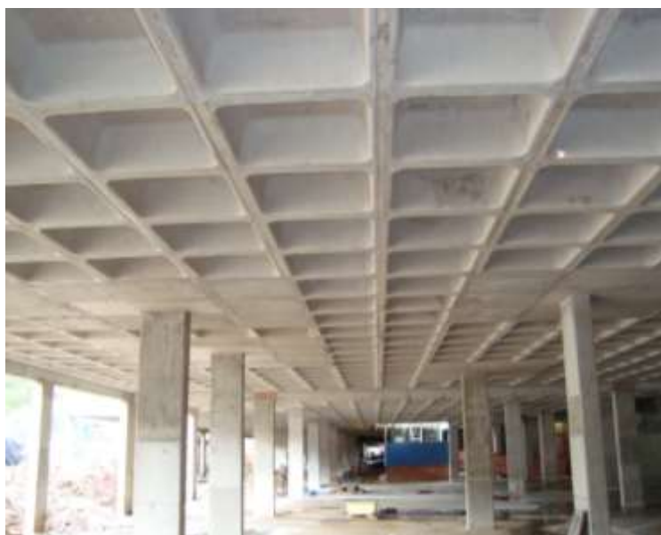
Figura 81: Acabamento da laje nervurada Fonte: ULMA Construction
