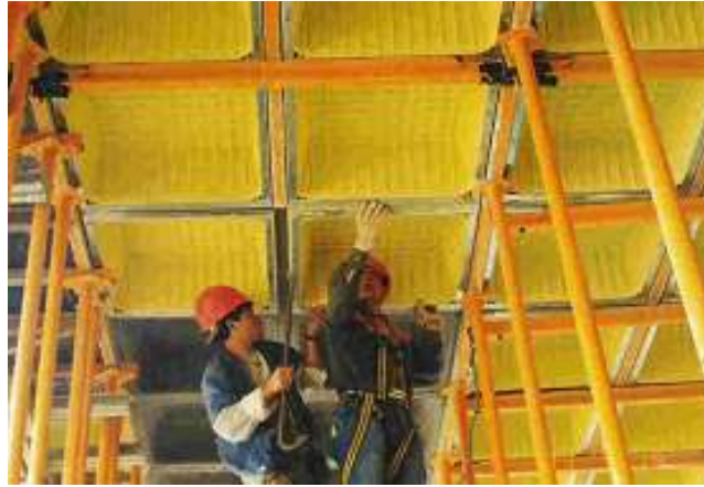
Figura 63: Desforma Fonte: ULMA Construction
