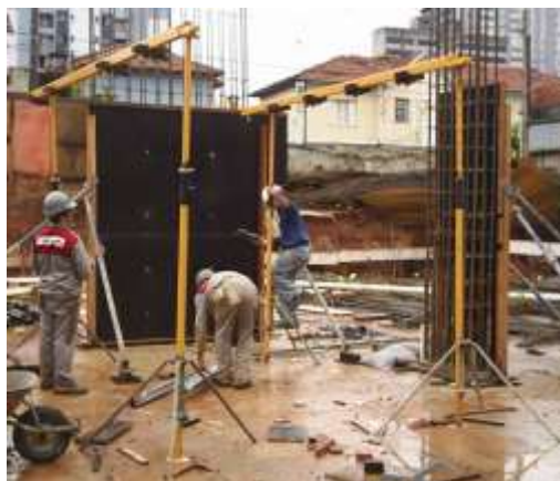
Figura 48: Elevação do longitudinal com os cabeçais instalados Fonte: ULMA Construction
