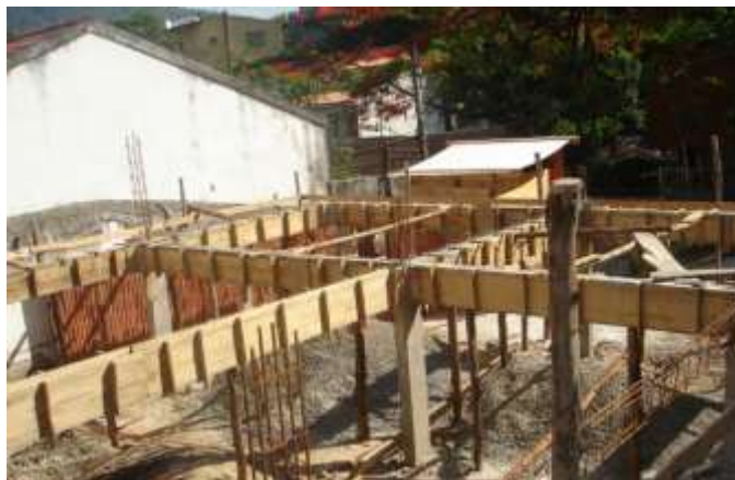
Figura 3: Utilização de tábuas para fôrmas de vigas Fonte: http://construcaomercado.pini.com.br/
