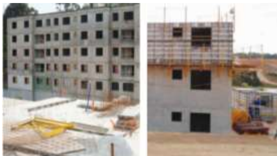
Figura 14: Fôrma de alumínio LUMIFORM SH, utilizada na construção de unidades habitacionais. Fonte: SH Fôrmas
