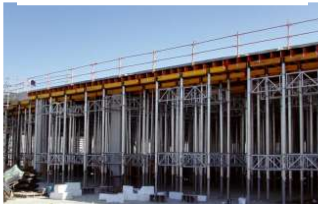
Figura 23: Escoramento utilizando ALUPROP Fonte: ULMA Construction
