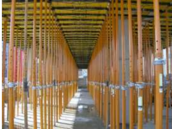
Figura 22: Escoramento utilizando escoras metálicas Fonte: ULMA Construction
