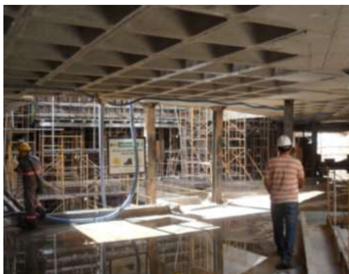
Figura 79: Edifício Forluz Fonte: ULMA Construction
