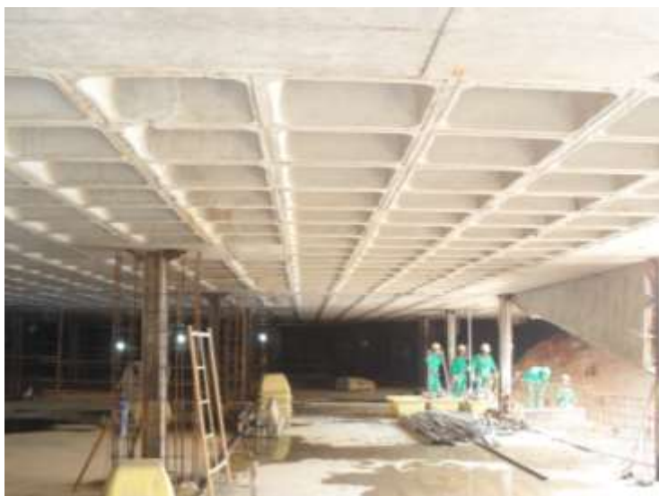
Figura 80: Laje nervurada Edifício Forluz Fonte: ULMA Construction
