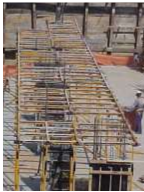
Figura 51: Montagem das transversais Fonte: ULMA Construction
