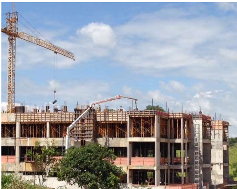
Figura 77: Construção do fórum de Divinópolis Fonte: ULMA Construction
