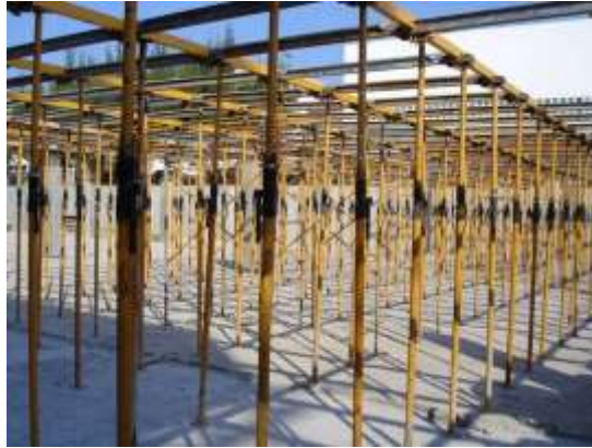
Figura 56: Conjunto montado e nivelado Fonte: ULMA Construction
