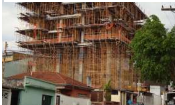
Figura 24: Escoramento utilizando torres metálicas CIMBRE G Fonte: ULMA Construction
