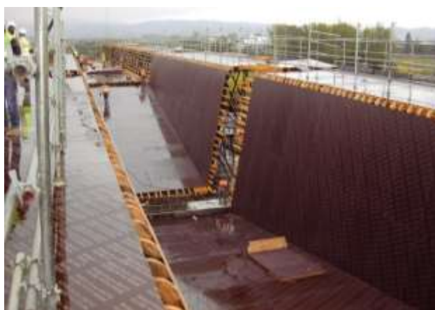
Figura 6: Utilização de compensado para fôrma de ponte.
