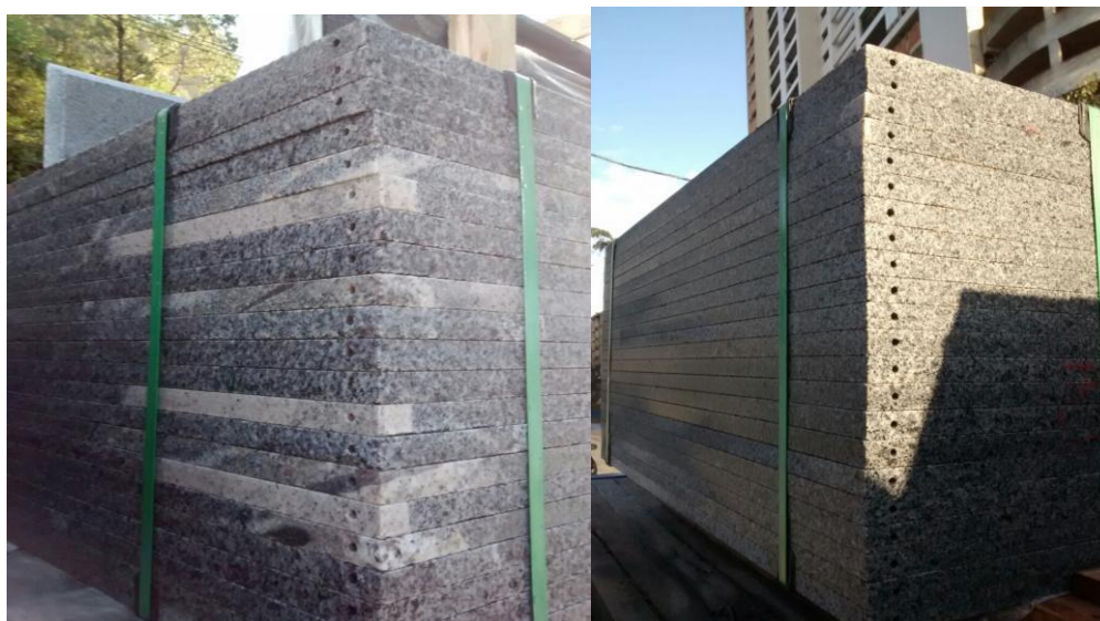
Foto 21 – Entrega do material com furações conforme o projeto
