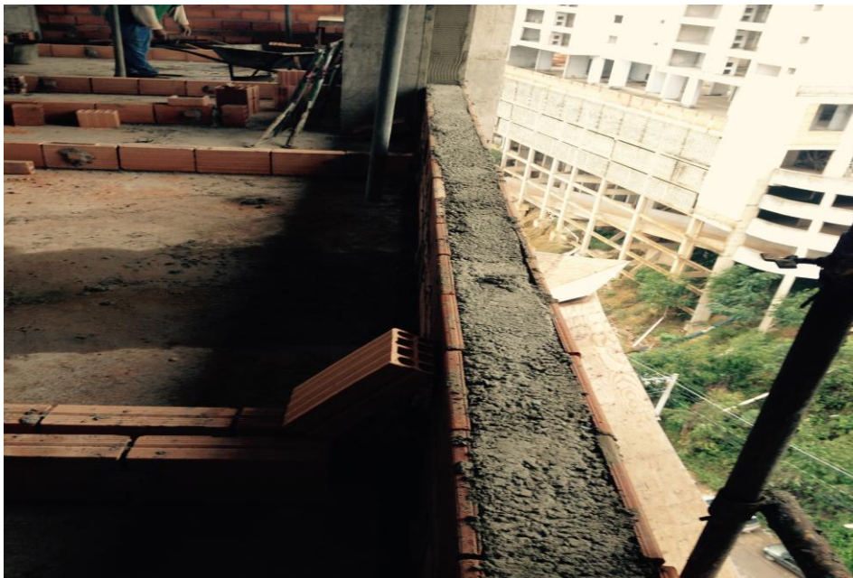
Foto17 – Preenchimento do bloco canaleta
