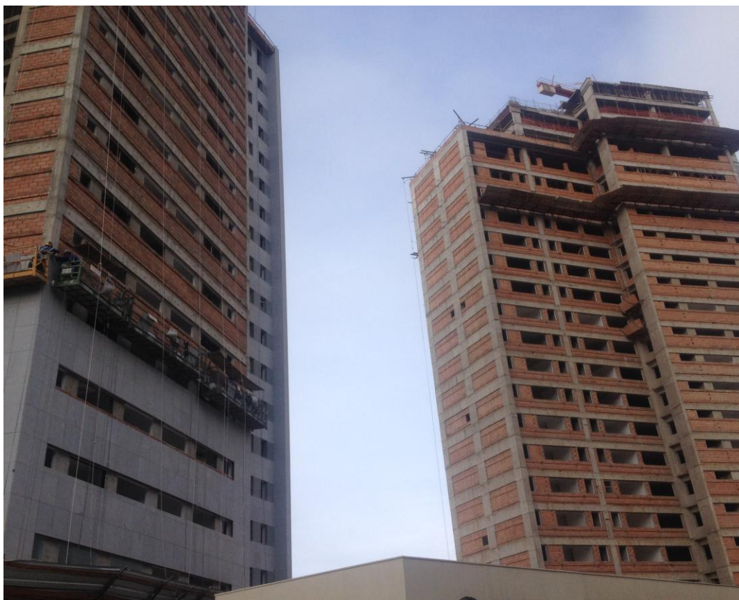
Foto 14 – Fase atual da obra
