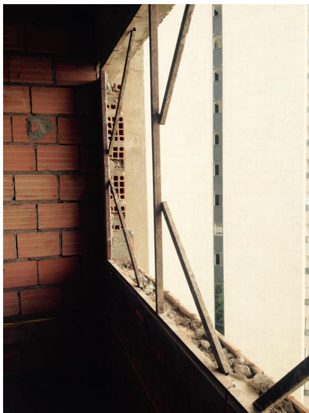
Foto 25 – Instalação do contramarco
