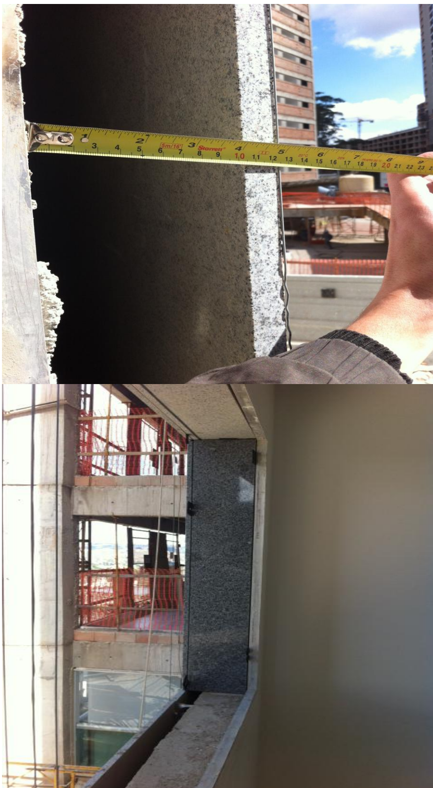
Foto 28 – Medição e instalação da requadrção
