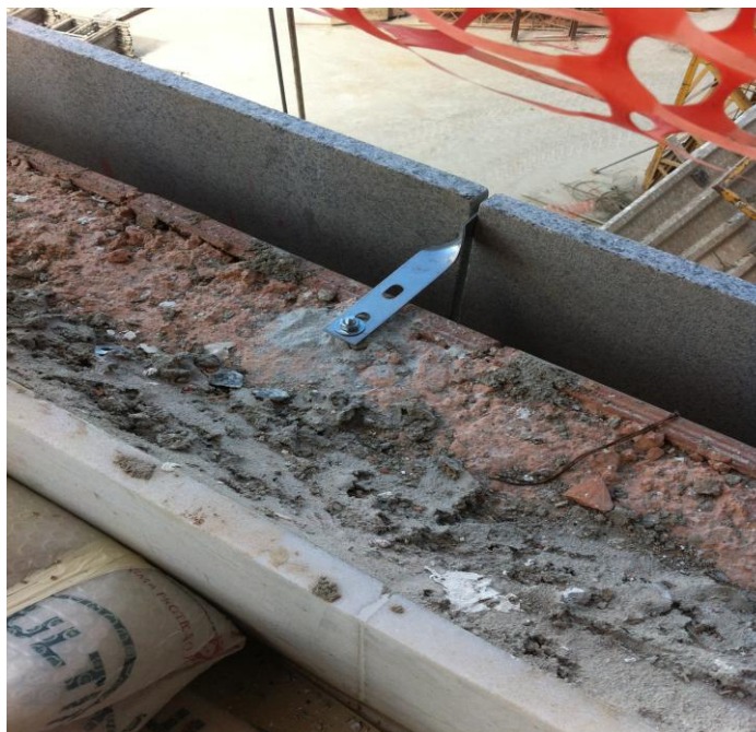
Foto 18 - Fixação de insert no bloco canaleta
