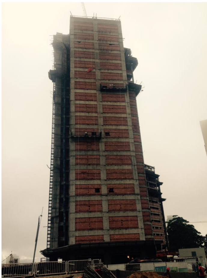
Foto 23 – Execução da preparação da base
