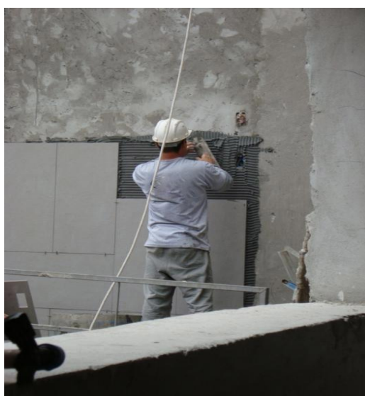
Foto 7 – Aplicação de granito com argamassa colante
