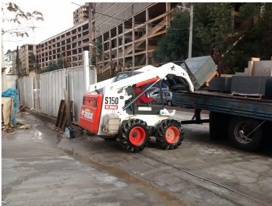
Foto 22 – Descarga mecanizada
