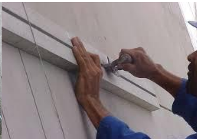
Foto 4 - Execução de juntas
