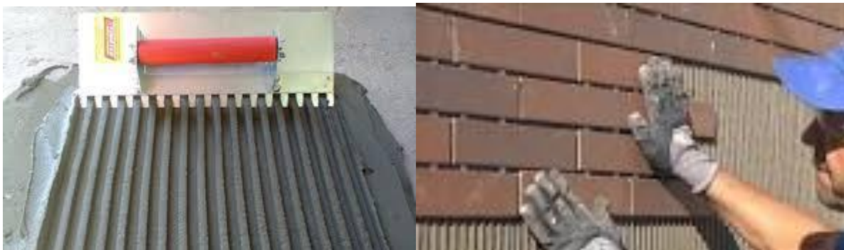
Foto 5 - (Aplicação da argamassa) Foto 6 - (Aplicação da cerâmica)
