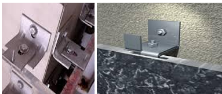
Figura 11- Sistemas com fixação de inserts metálicos
