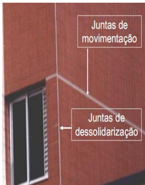
Figura 12 – Juntas de movimentação e dessolidarização
