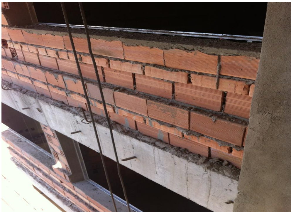
Foto 19 – Estrutura e faixas de bloco canaleta
