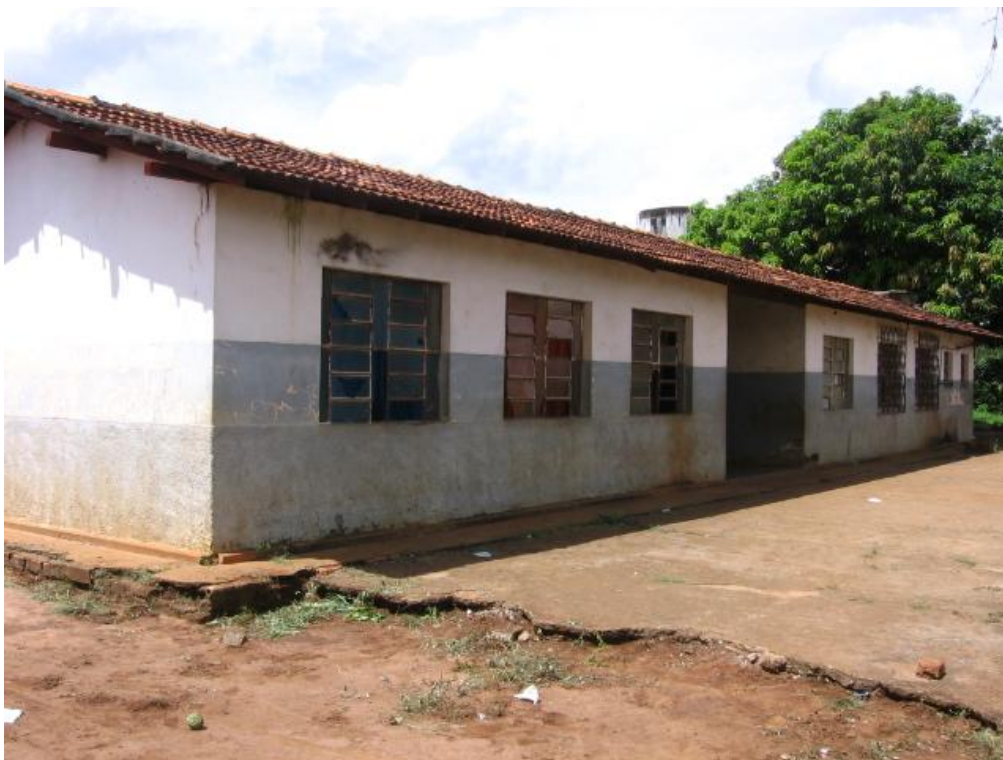
Figura 4 Imagem da fachada da escola demolida
