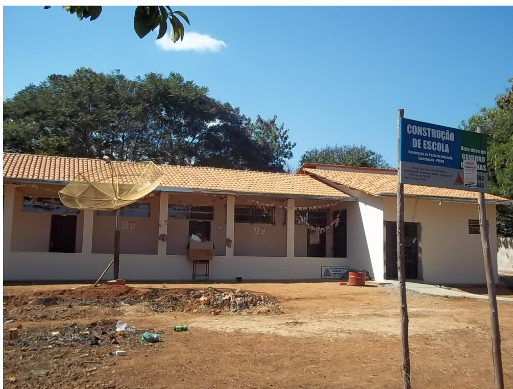
Figura9- Casa Escola sem autorização prévia da S.E.E modificada em função da segurança.
