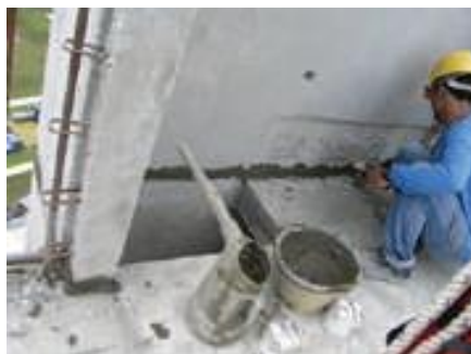
Figura 20 – Aplicação de argamassas na junta horizontal Fonte: BCA
