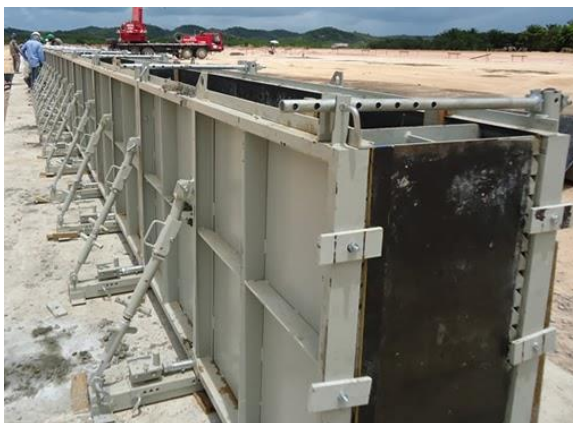
Figura 15 – Fôrma metálica para pré-fabricados Fonte: Blog Concreto pré-moldado e pré-fabricado BH.
