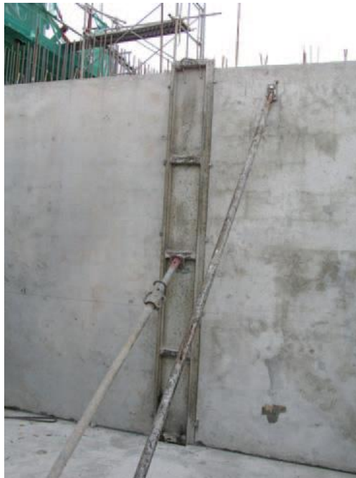
Figura 22 – Fôrma para graute nas juntas horizontais Fonte: BCA
