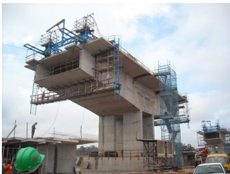
Figura 13 – Montagem por balanços sucessivos Fonte: Rosenblum (2009)
