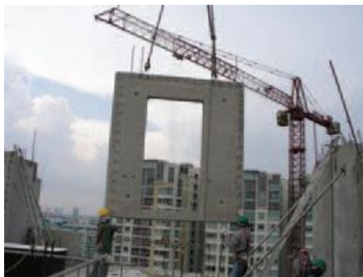
Figura 18 – Içamento de painel pré-moldado Fonte: BCA
