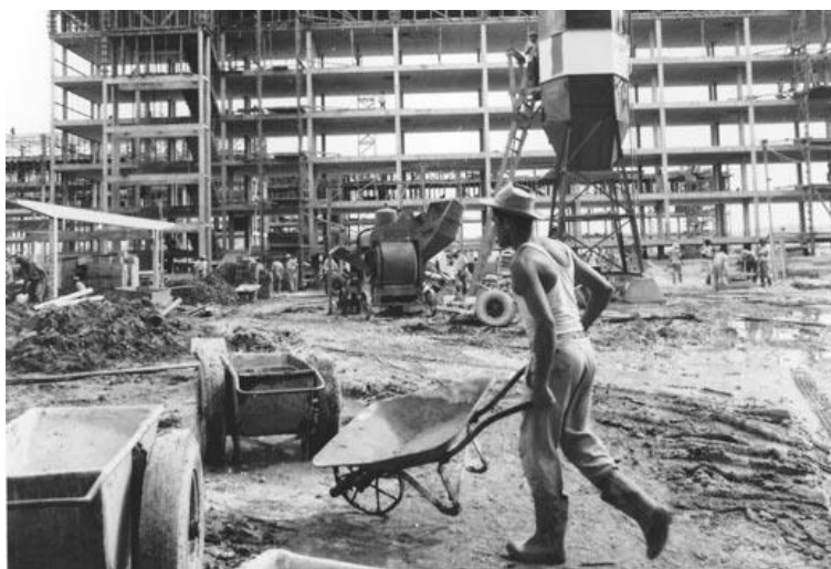
Figura 3 – Construção do CRUSP Fonte: Acervo Digital da USP.
