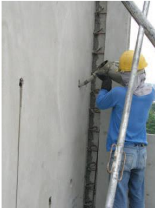
Figura 21 – Aplicação de graute para solidarização da estrutura Fonte: BCA
