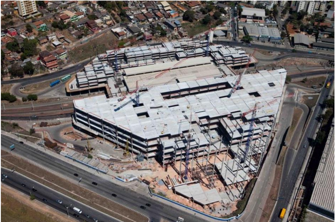
Figura 11 – Construção do Shopping Estação e da Estação Vilarinho Fonte: Obras BH
