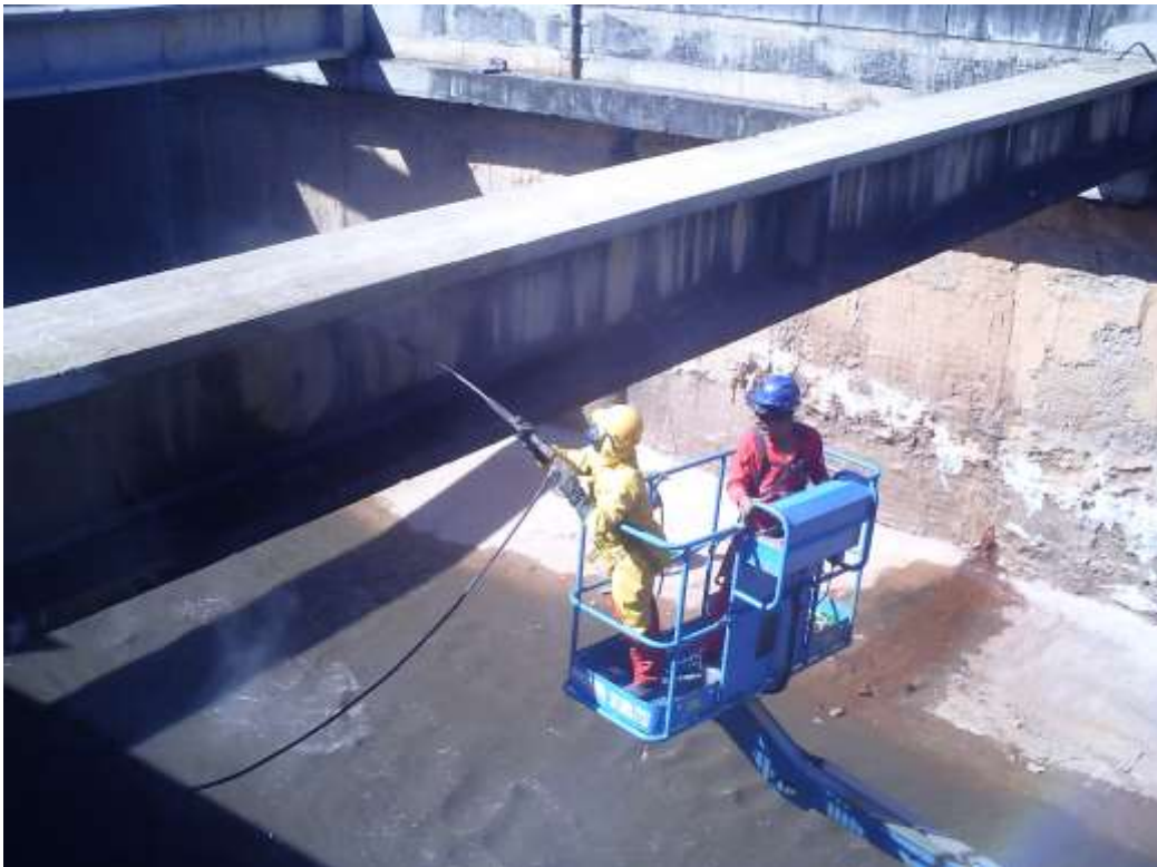
Figura 4.18 –Aplicação do inibidor de corrosão, utilizando pistola pneumática de baixa pressão (Fonte: ACERVO PESSOAL, 2009)
