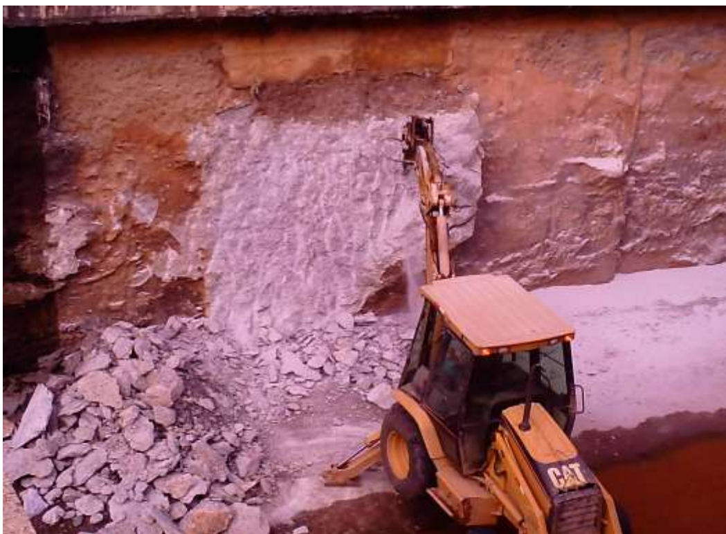
Figura 4.12 – Remoção das áreas contaminadas expondo a armadura, com a utilização de martelo rompedor pneumático (Fonte: ACERVO PESSOAL, 2009)
