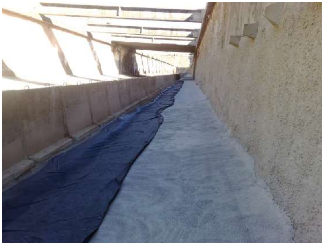
Figura 4.11 – Cura úmida com utilização de mantas tipo bidim (Fonte: ACERVO PESSOAL, 2009)
