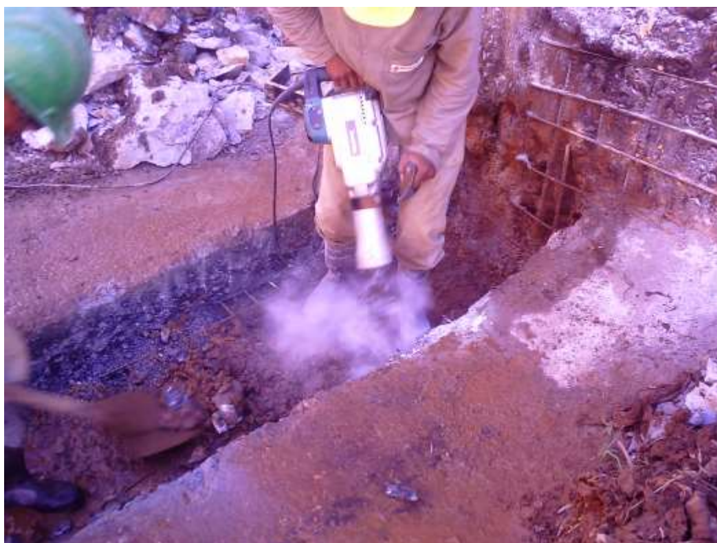
Figura 4.5 – Demolição da faixa demarcada pelo disco de corte, utilizando rompedor pneumático
