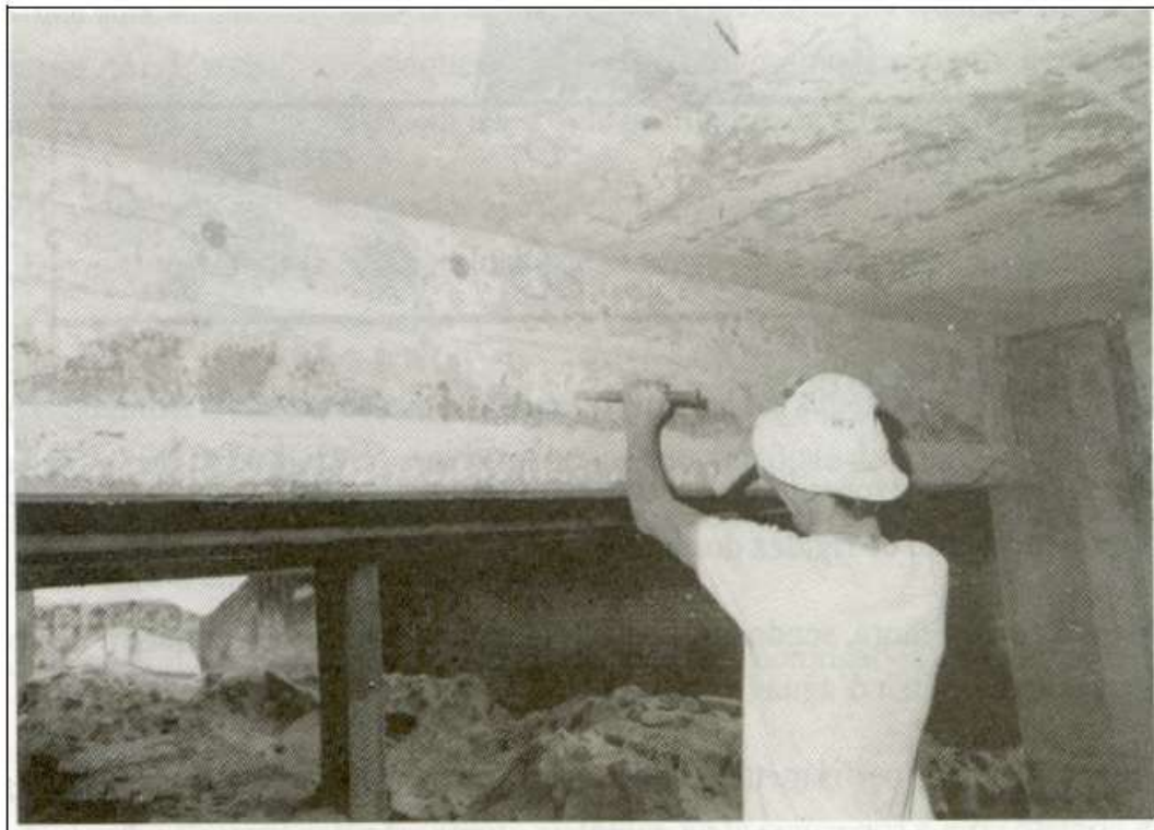
Figura 3.16 – Remoção manual do concreto danificado (Fonte: SOUZA e RIPPER, 1998)
