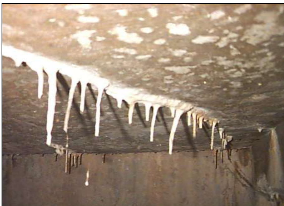
Figura 3.1 – Lixiviação (Fonte: RECUPERAÇÃO, 2010)
