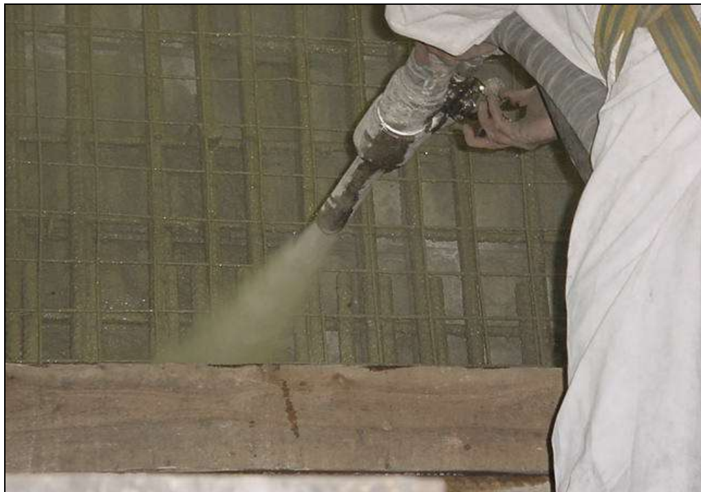
Figura 3.27 – Aplicação do Concreto projetável (Fonte: RECUPERAÇÃO, 2010)
