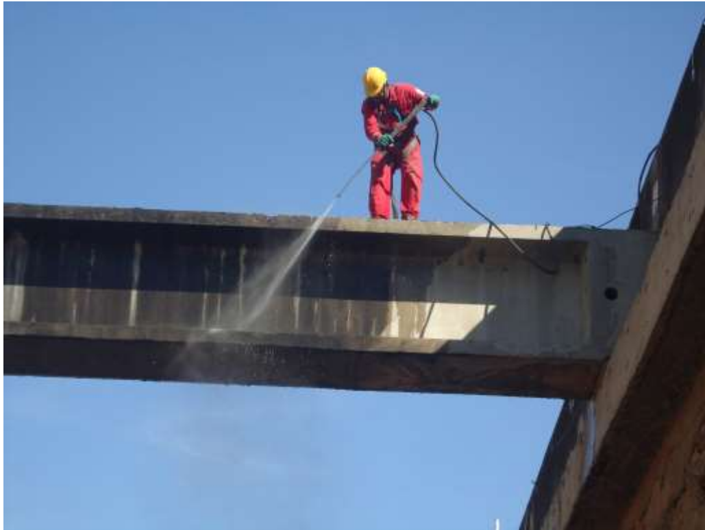
Figura 4.17 – Limpeza das vigas estroncas, idêntica a parede de diafragma (Fonte: ACERVO PESSOAL, 2009)
