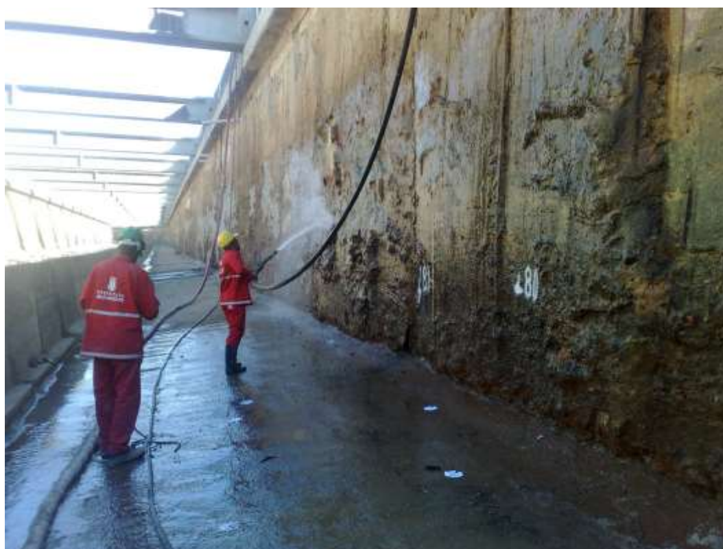
Figura 4.13 – Limpeza da parede de diafragma, utilizando jateamento de água com pressão (Fonte: ACERVO PESSOAL, 2009)
