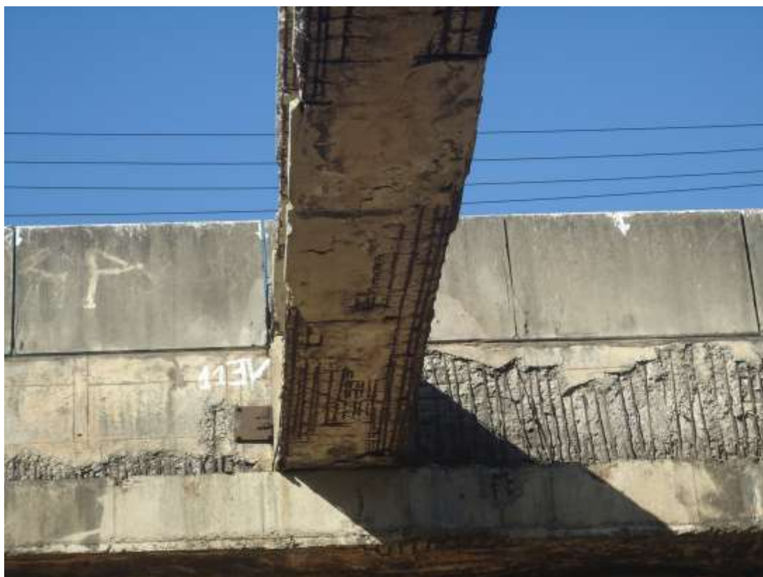
Figura 4.16 – Recuperação das vigas estroacas, idêntica a parede de diafragma (Fonte: ACERVO PESSOAL, 2009)
