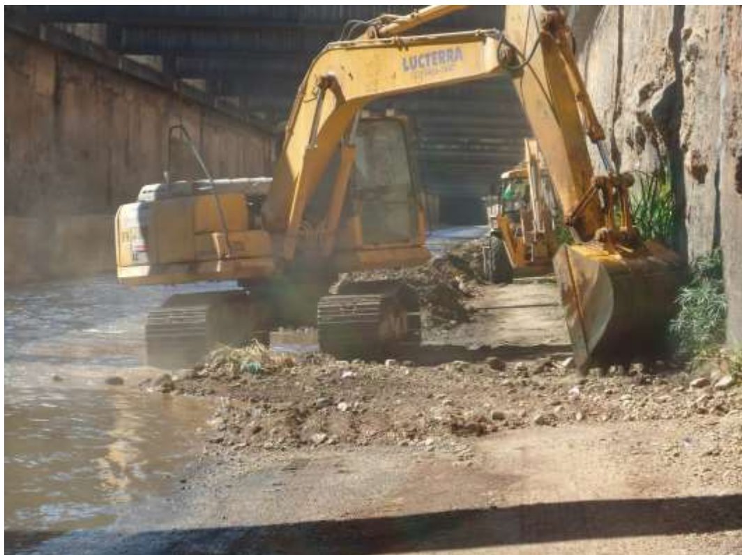
Figura 4.3 – Remoção da vegetação e sujeiras existentes no canal (Fonte: ACERVO PESSOAL, 2009)
