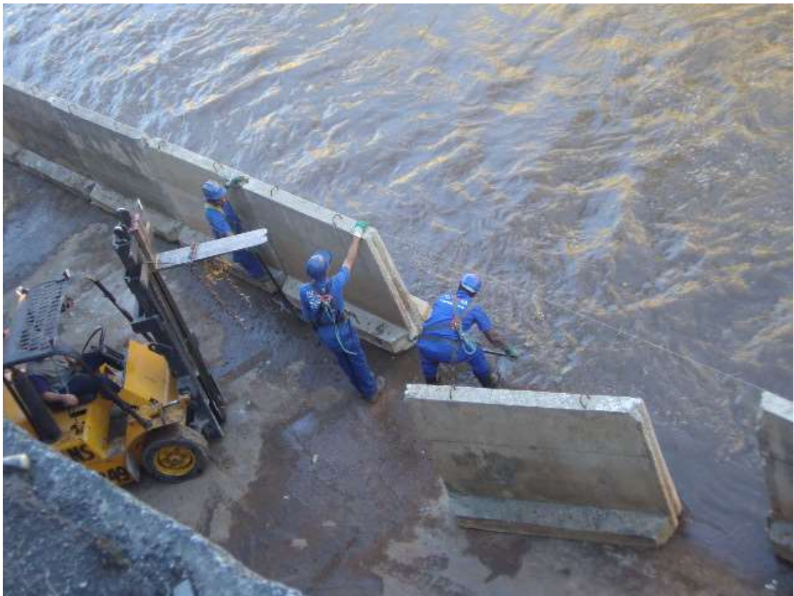
Figura 4.20 – Ensecamento da laje de fundo, colocação do corta-rio (Fonte: ACERVO PESSOAL, 2009)
