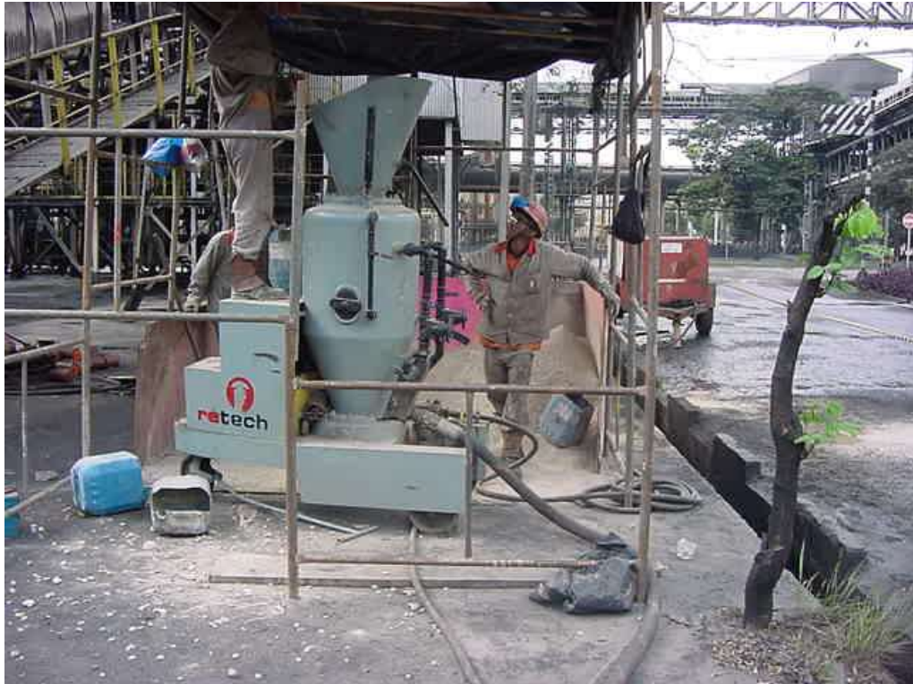
Figura 3.26 – Equipamento de mistura do concreto projetável (Fonte: RECUPERAÇÃO, 2010)
