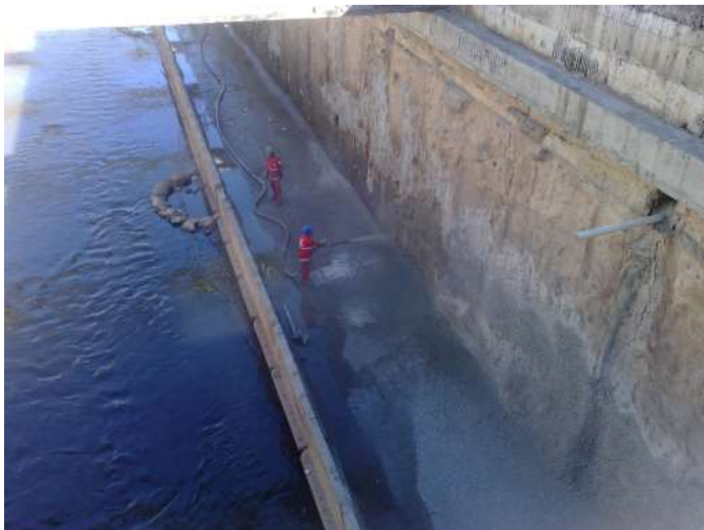
Figura 4.15 – Reforço da parede de diafragma com concreto projetado (Fonte: ACERVO PESSOAL, 2009)
