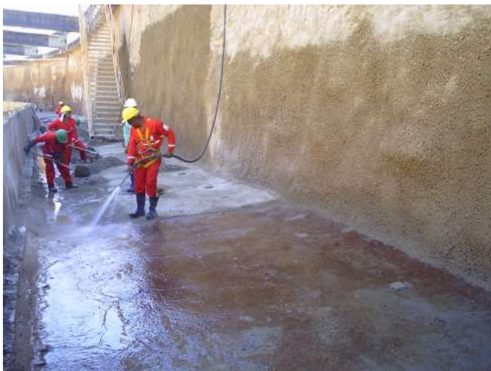
Figura 4.9 – Limpeza por jateamento de água com pressão removendo sujeiras na largura das faixas (Fonte: ACERVO PESSOAL, 2009)
