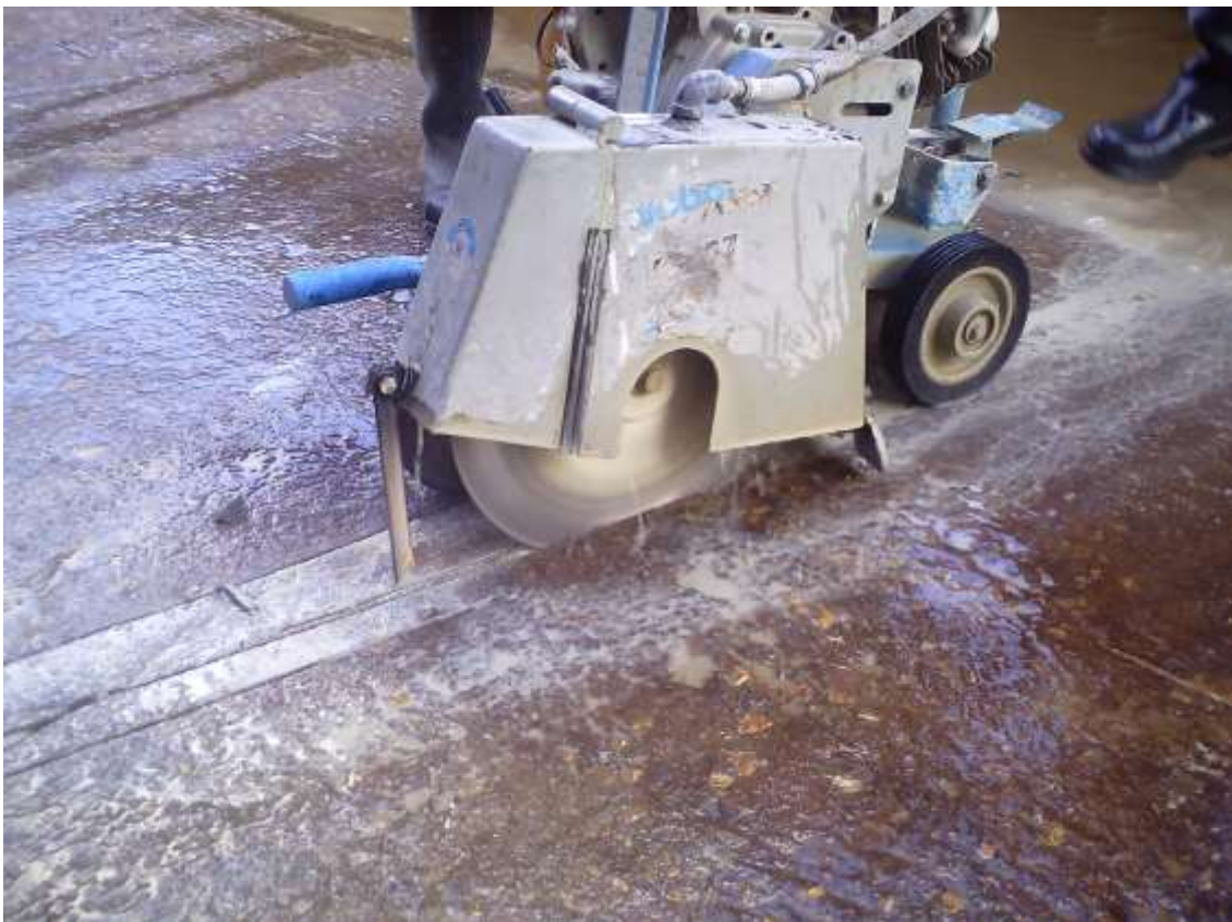
Figura 4.4 – Corte do concreto para tratamentos das trincas transversinas, utilizando equipamento de disco de corte (Fonte: ACERVO PESSOAL, 2009)
