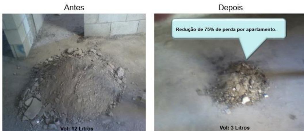
Figura 5.29 – Entulho gerado antes e depois do tratamento da anomalia
