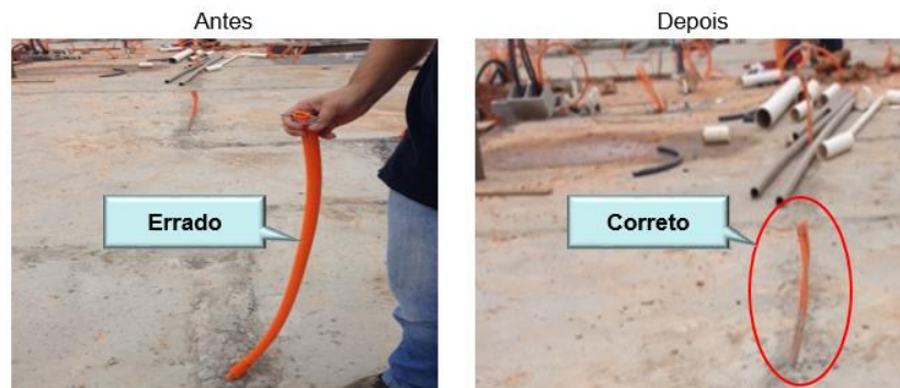
Figura 5.45 – Correção do procedimento de execução e diminuição da variabilidade
