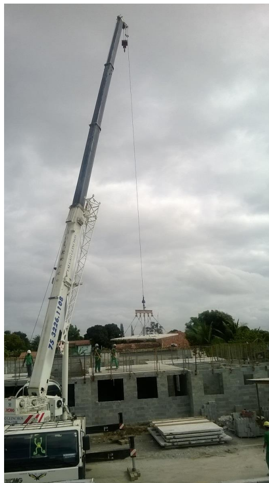
Figura 5.46 – Laje no processo de içamento
