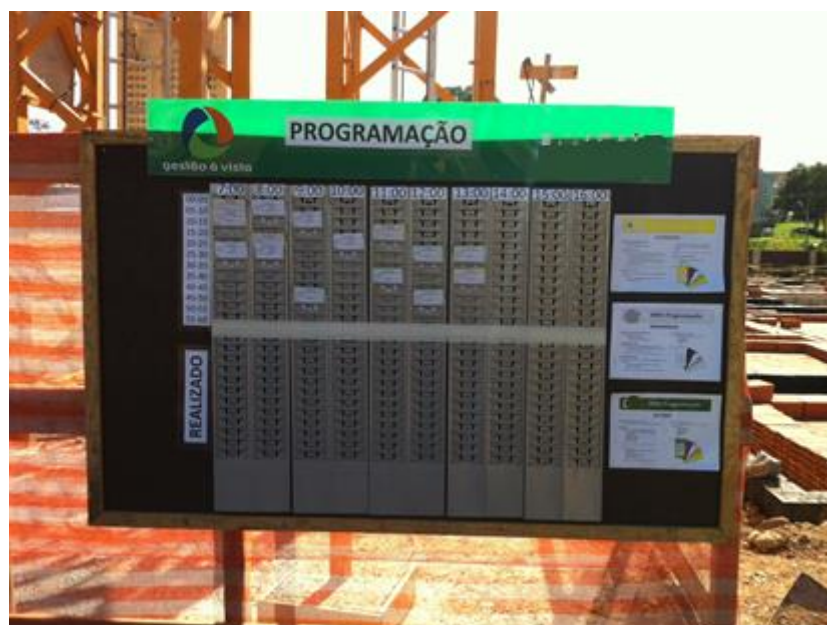
Figura 5.39 – Painel porta-Kanban na obra
