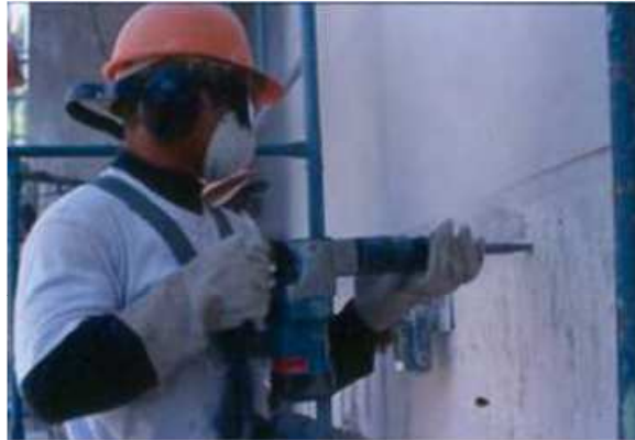
Figura 8- Escarificação mecânica.
