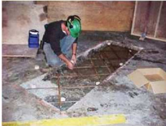
Figura 21- Ânodos de sacrifício discretos.
