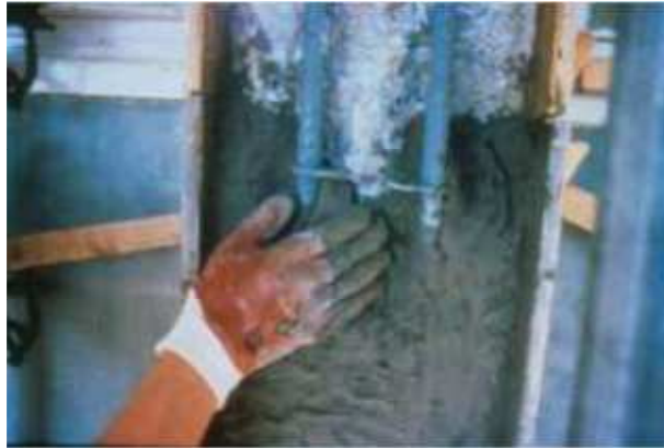
Figura 14- Colocação manual de argamassa. (FONTE: MUÑOZ et al, 2003)
