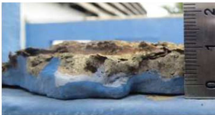
Figura 38- Medida da espessura de cobrimento nas vigas Vierendeel.
