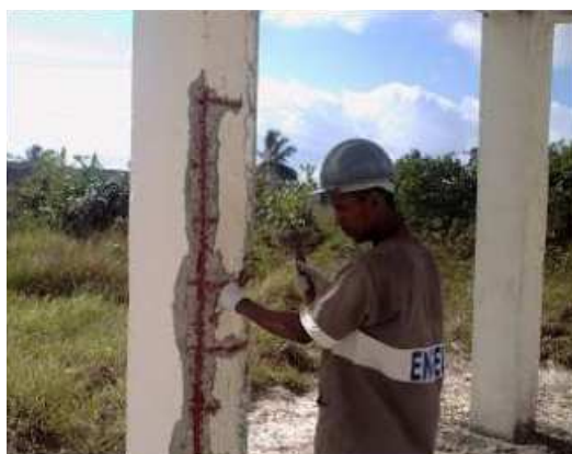
Figura 7- Escarificação manual.
