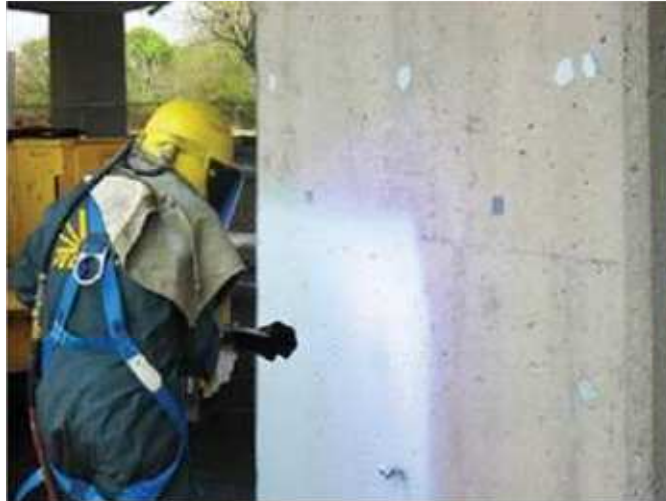
Figura 22- Capas metálicas aplicadas por spray.
