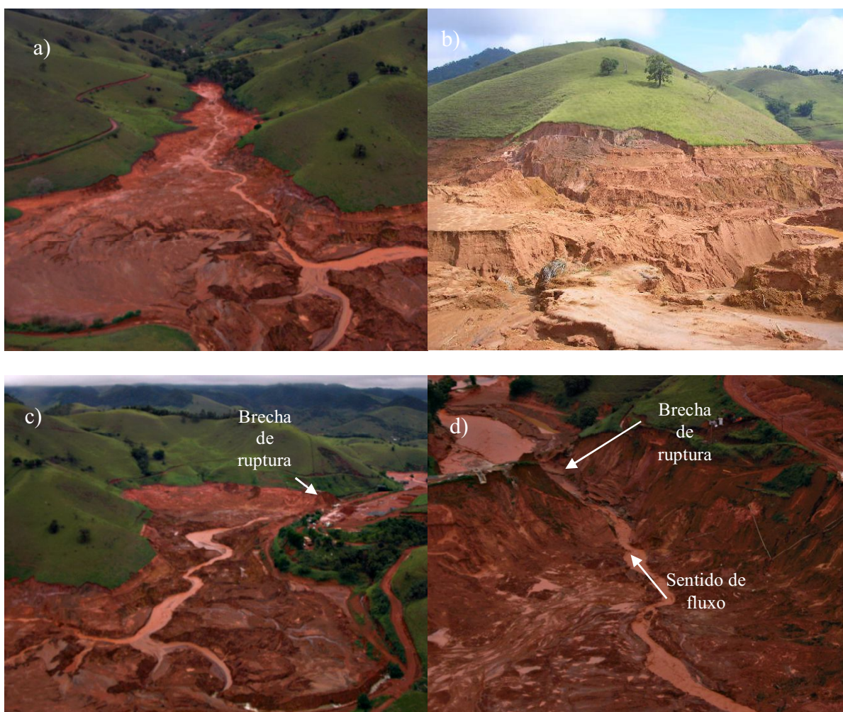
Figura 5.2 – Diferentes porções do reservatório após a ruptura
