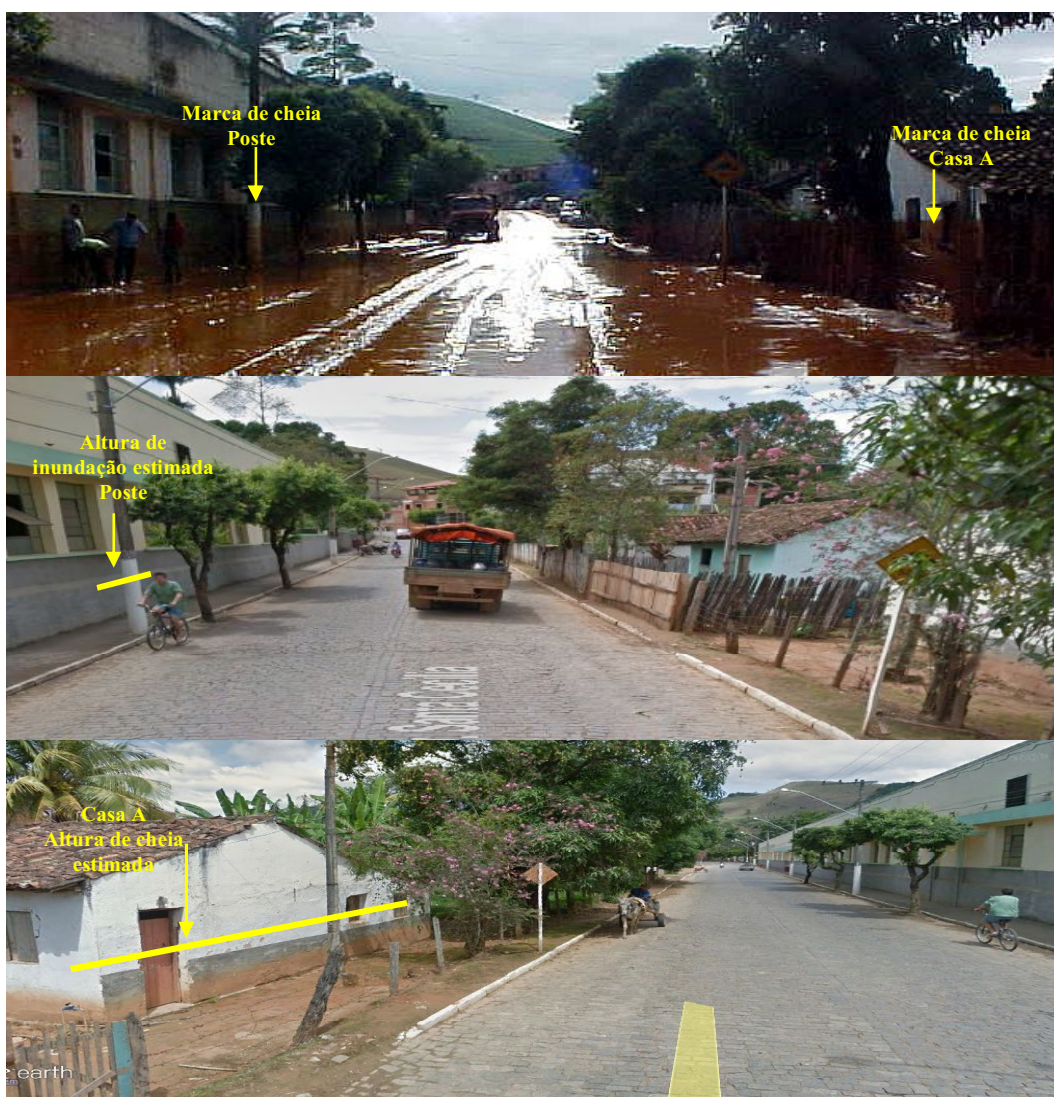
Figura 5.20 – Estimativa da altura de inundação – exemplo da Av. Santa Cecília
