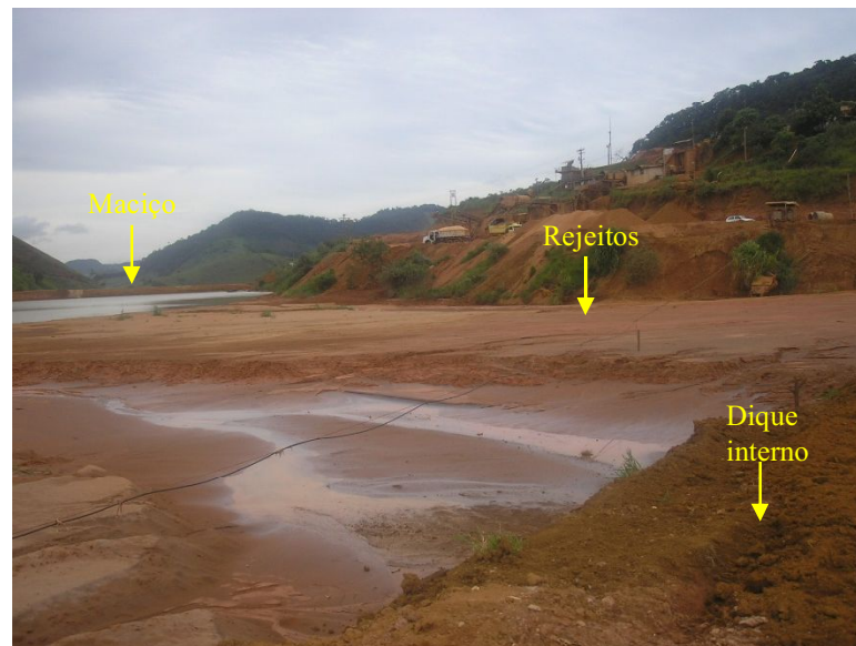
Figura 5.6 – Dique Interno – vista para jusante (abril de 2006)
