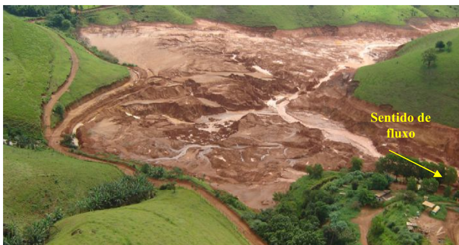
Figura 5.1 – Situação do reservatório após a ruptura
