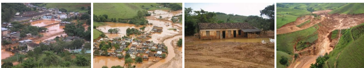
Figura 4.5 – Fotografias registradas após o evento de ruptura da barragem São Francisco em janeiro de 2007
