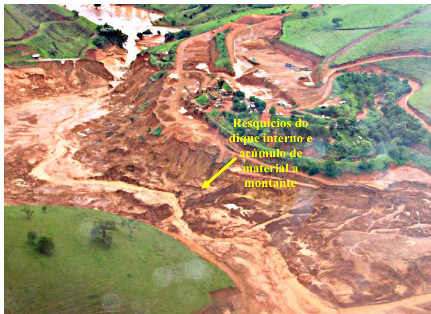
Figura 5.7 – Resquícios do dique interno após a ruptura da barragem
