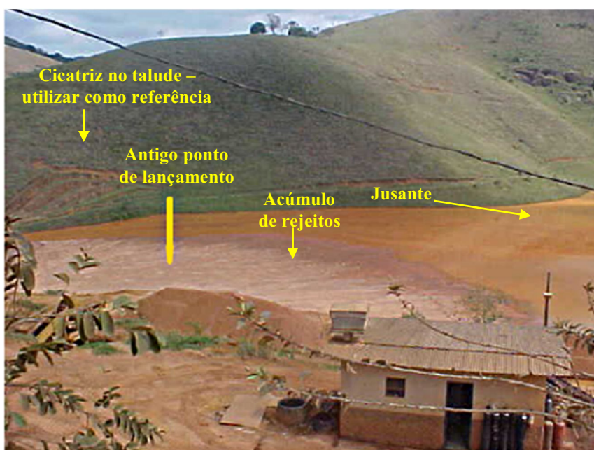
Figura 5.3 – Antigo ponto de lançamento de rejeitos no reservatório da barragem São Francisco
