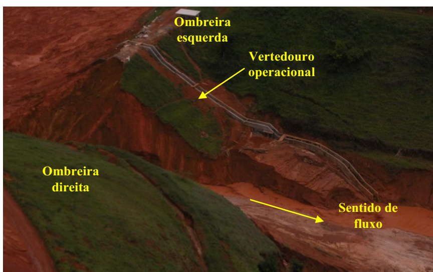
Figura 5.11 – Ruptura do maciço da barragem São Francisco – detalhe para o vertedouro que permaneceu intacto: vista lateral
