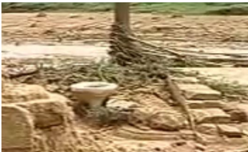
Figura 6.30 – Edificação da área rural localizada logo a jusante da barragem – colapso total Fonte: Globo Rural (2007).
