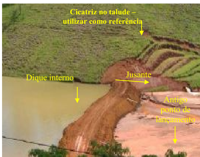
Figura 5.5 – Dique interno construído em 2006
