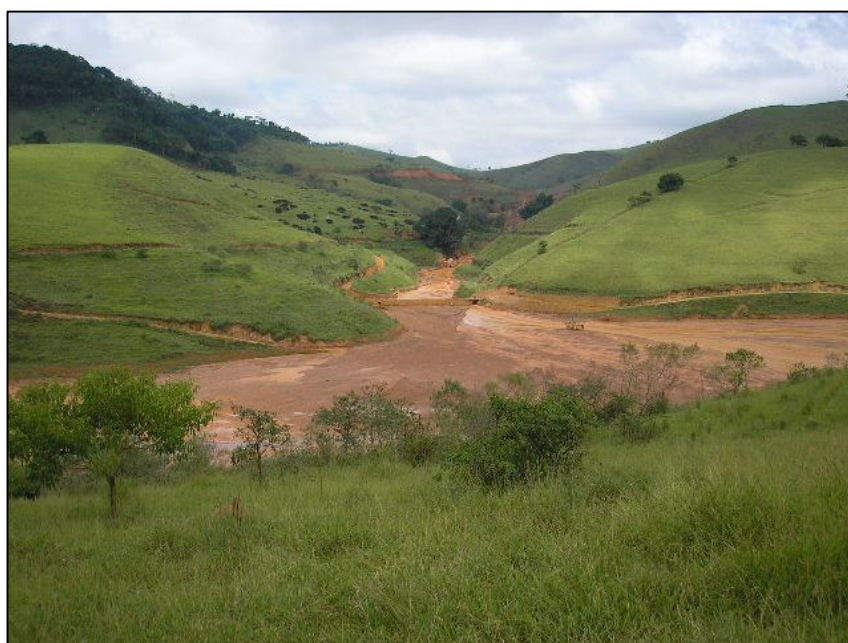
Figura 6.27 – Várzea localizada a cerca de 2 km a jusante da barragem
