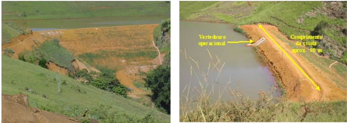
Figura 4.2 – Vista da crista e do talude de jusante da barragem
